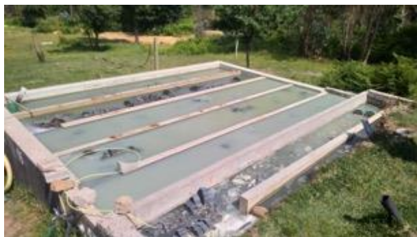
Figura 3-15- Tanques 15, 16 e 16A
