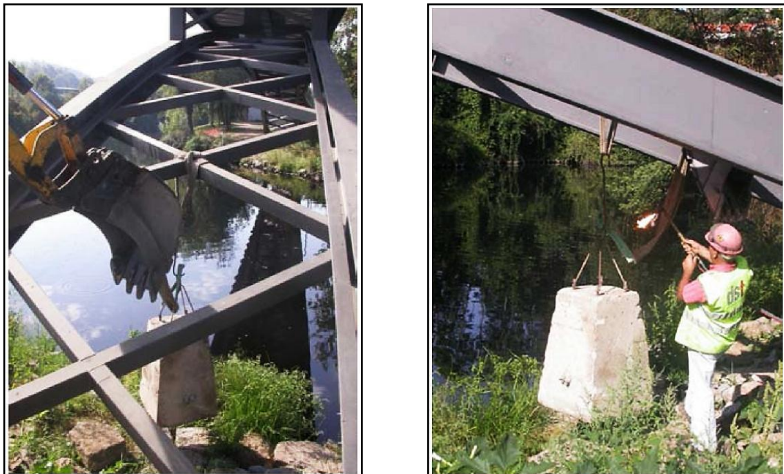
Fig.5.12. – Operações de suspensão do bloco e corte do gancho durante os ensaios de vibração livre
