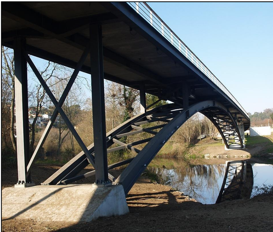
Fig.4.5. – Vista lateral da ponte
