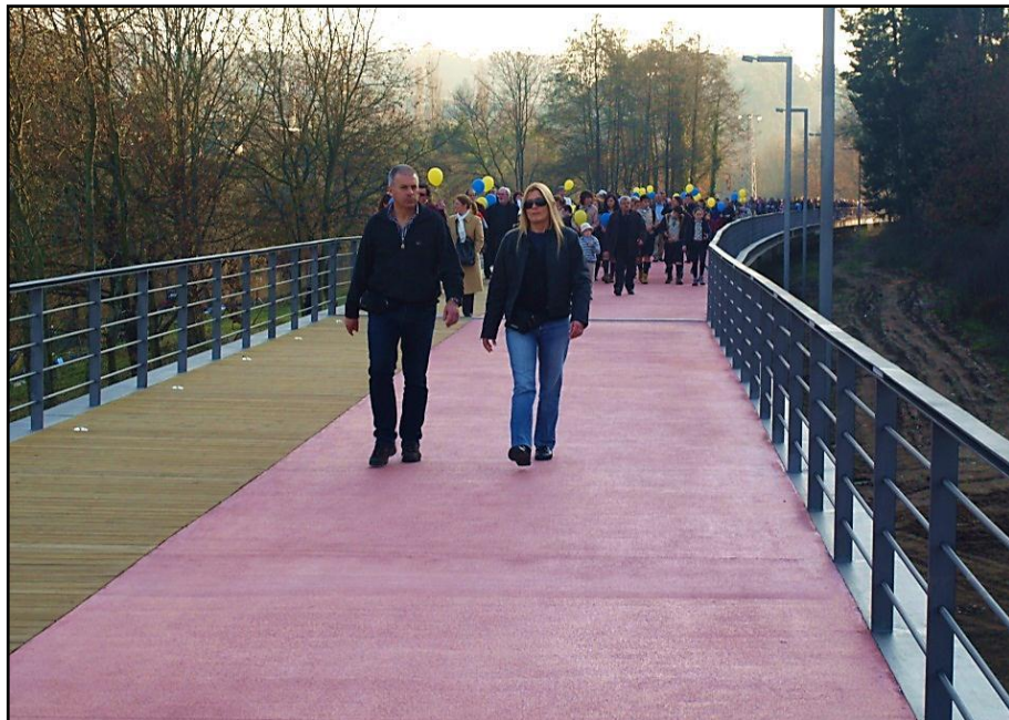
Fig.4.7. – Vista da face superior do tabuleiro
