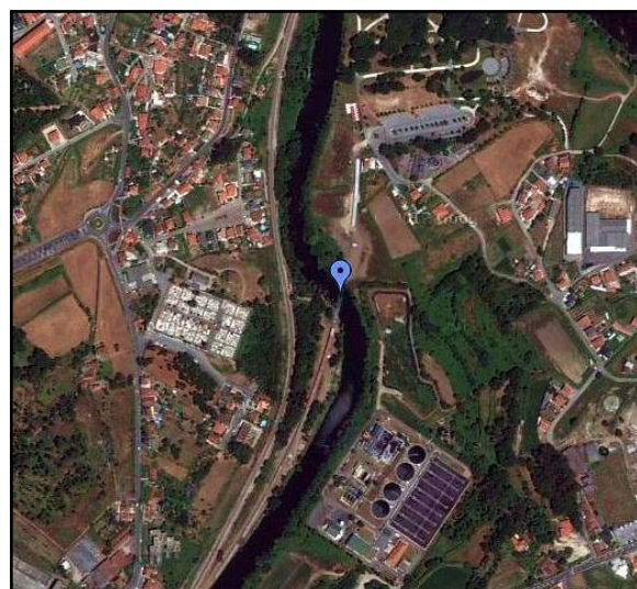
Fig.4.2. – Vista aérea do local da obra [20]
