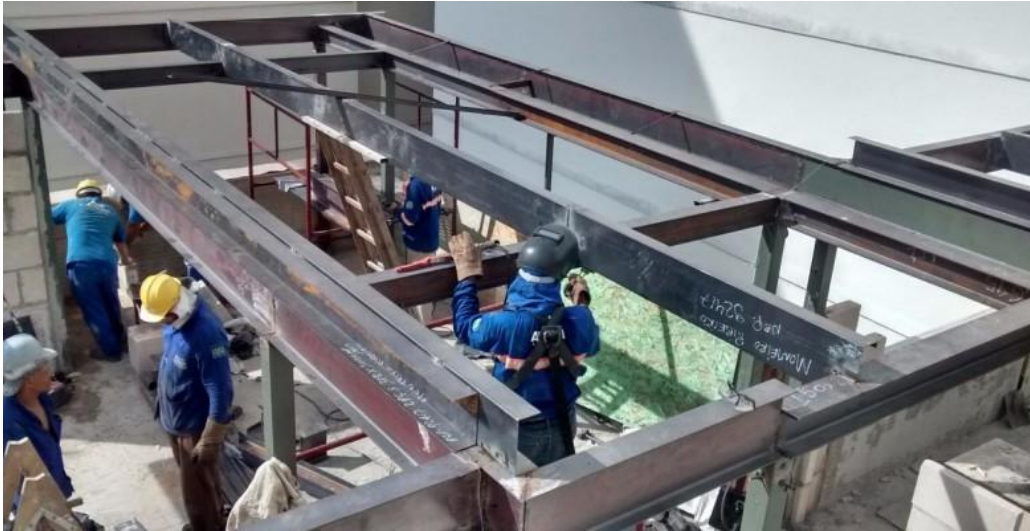
Figura 27. Exemplo da montagem de uma estrutura metálica [82]
