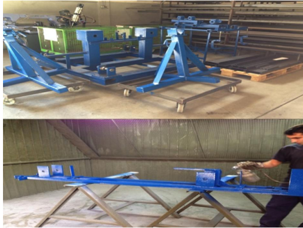
Figura 46 – Pintura dos Moldes
