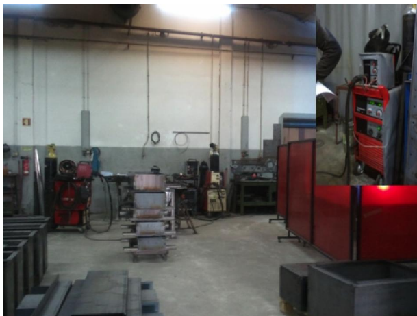
Figura 9 – Zona de montagem de Estruturas metálicas
