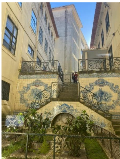
Figura 1 - Escola (parte externa)
