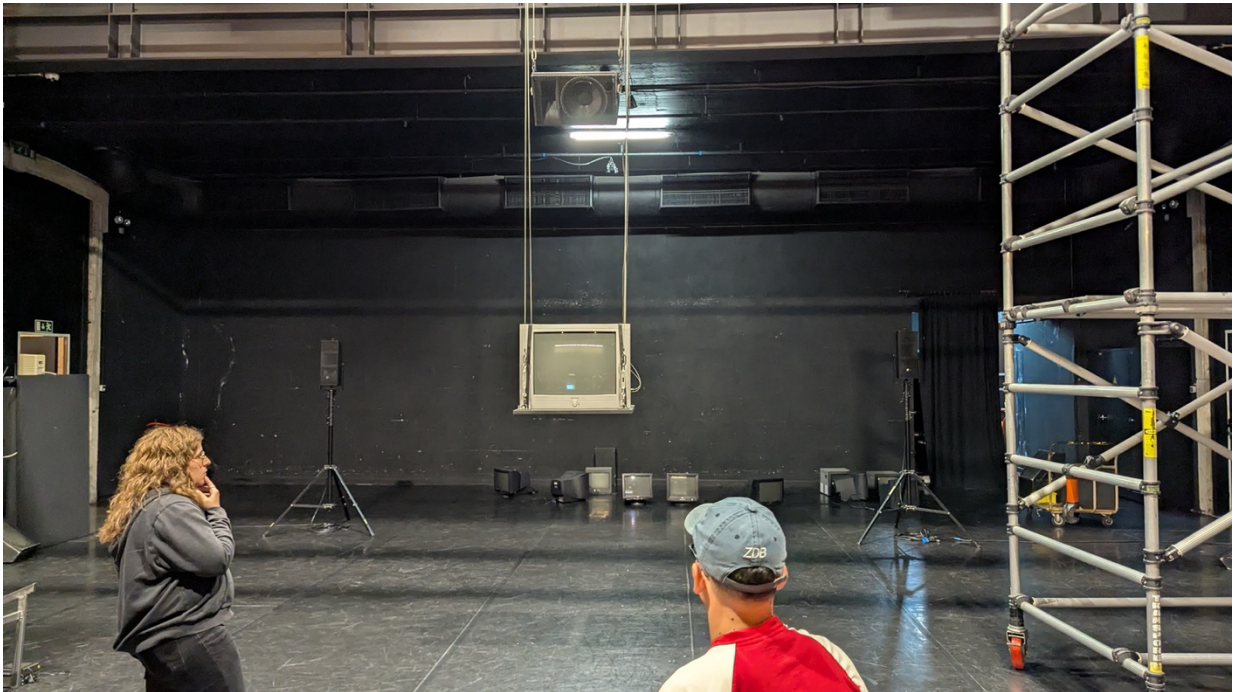
7. Montagem do Overlord no THSC
