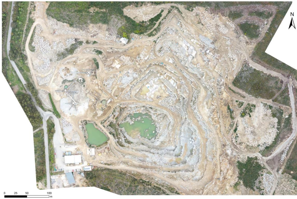
Figura 49 – Ortofoto de pormenor para o desenvolvimento dos mapas de zonamentos geotécnico e geomecânico (março 2022). Foto aérea gentilmente cedida por BRITAFIEL, S.A..
