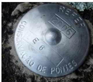
Figura 2.3 – Identificação da última intervenção realizada na ponte da Baia.
