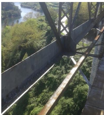
a) Pormenor da corda inferior
