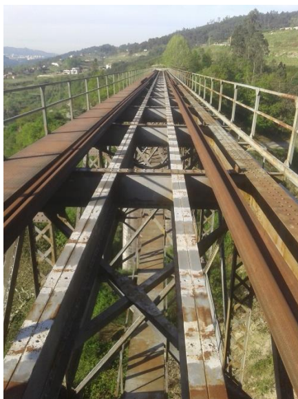
Figura 3.6 – Pormenor do posicionamento dos carris.
