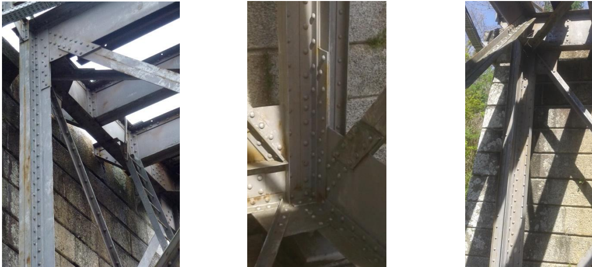
a) Vista geral b) Pormenor do reforço da extremidade inferior c) Vista pelo interior do tabuleiro
