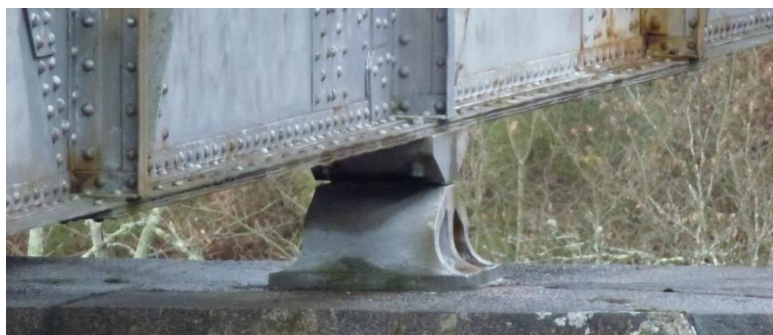
Figura 2.14 – Reforço da corda inferior da viga treliça.
