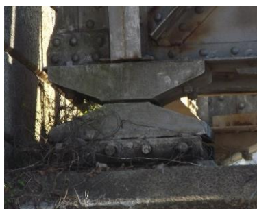
a) Aparelho de apoio localizado no encontro da ponte (no lado de Livração)
