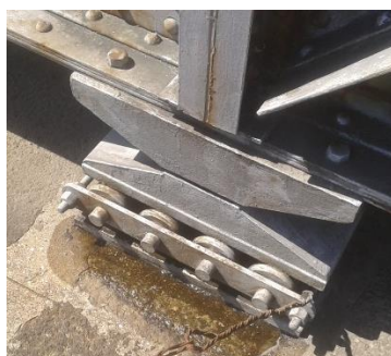
b) Vista superior de aparelho de apoio localizado num pilar
