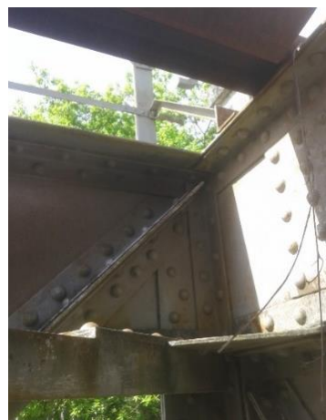
b) Pormenor do nó de ligação entre a corda superior, a carlinga e o montante
