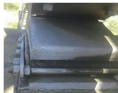
c) Vista lateral do aparelho de apoio localizado num pilar
