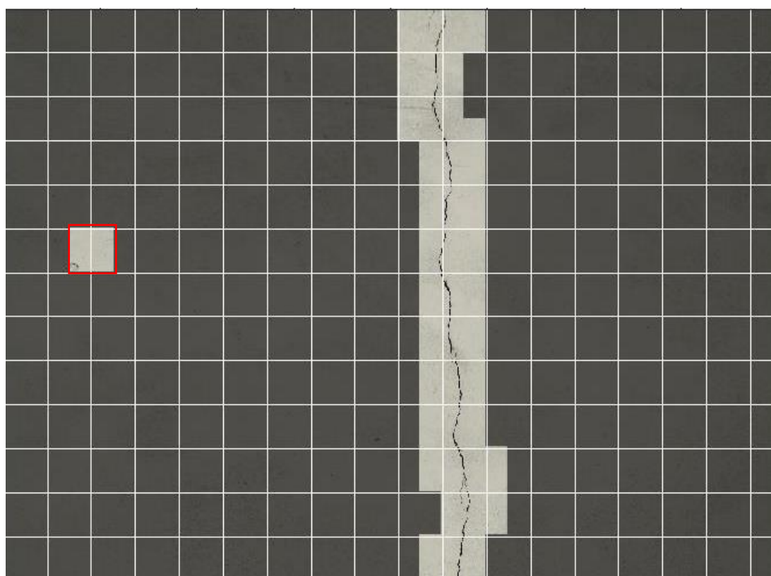
Figura 6-14 - Imagem 4 (Abordagem 1 (RNC), Fissuras, Unidade Hoteleira)
