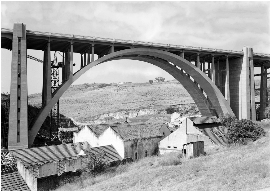
Figura 2-1 - Viaduto Duarte Pacheco em Lisboa (Restos-de-coleção, 2013)
