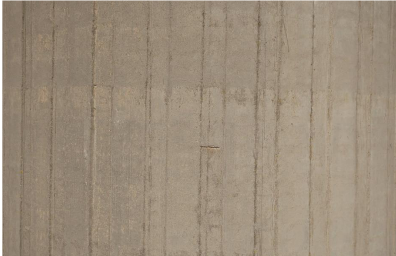
Figura 6-46 – Imagem 2 (Original, Armaduras expostas, Torre Altice)
