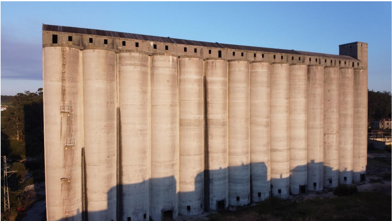
Figura 6-18 - Edifício em estudo (visto do Bairro do Rio Ave)
