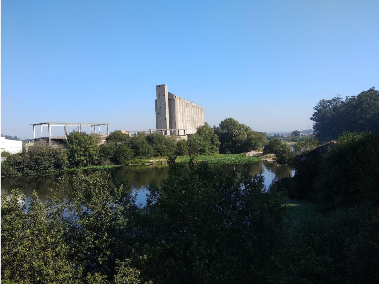
Figura 6-17 - Edifício em estudo (visto da ponte de Formariz)
