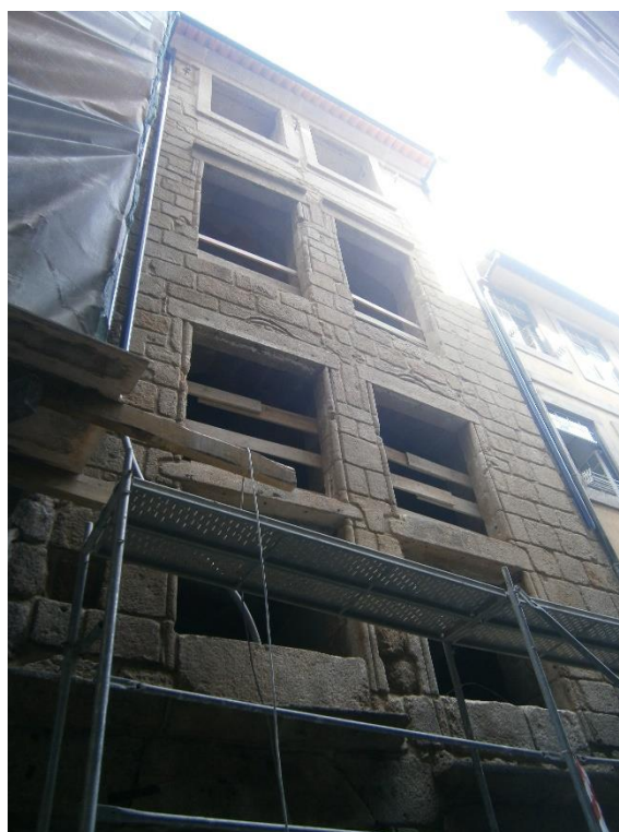
Figura 4.31 - Fachada depois da intervenção
