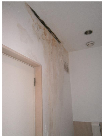
Figura 4.20 – Paredes e teto do WC
