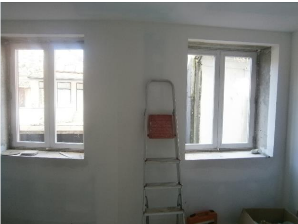
Figura 4.55 - Janelas já colocadas
