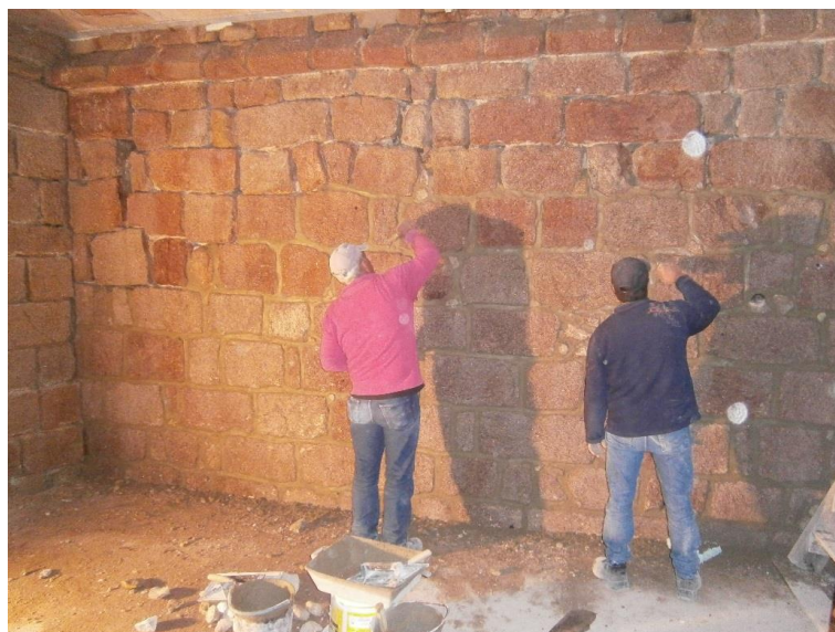
Figura 4.30 - Execução das juntas
