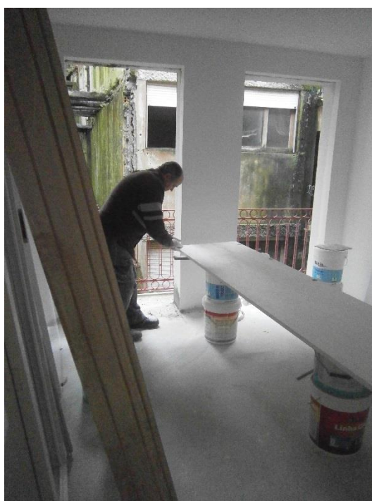
Figura 4.52 - Montagem das Janelas
