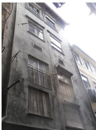
Figura 4.26 - Fachada Principal – Antes de intervenção (Fonte: Porto Vivo, SRU)
