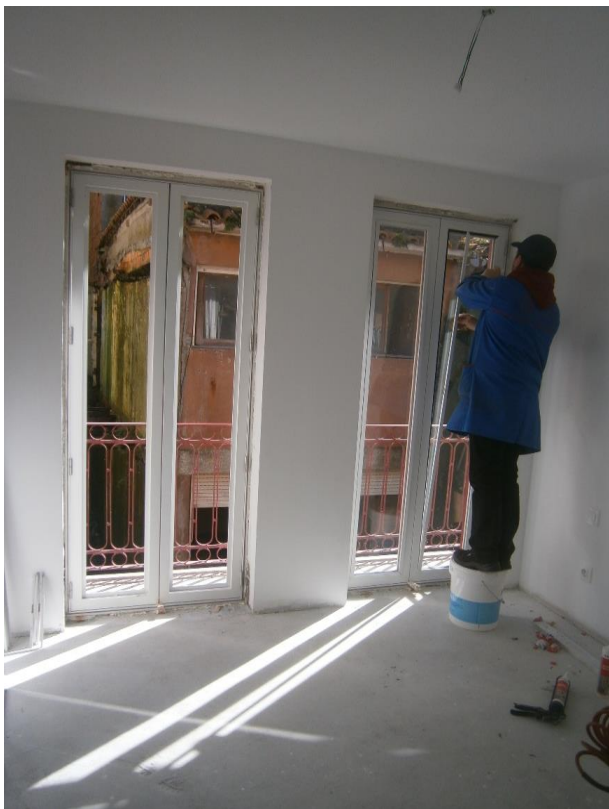
Figura 4.63 - Colocação dos Vidros
