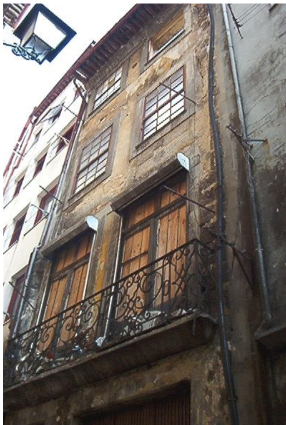
Figura 4.32 - Fachada principal - Antes de intervenção (Fonte: Porto Vivo, SRU)
