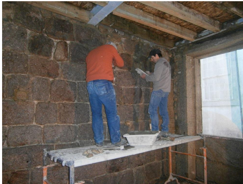
Figura 4.34 - Execução das juntas
