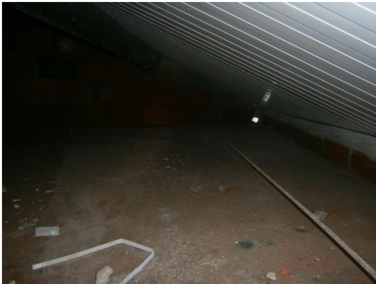
Figura 4.29 - Cobertura Sandwich já colocada
