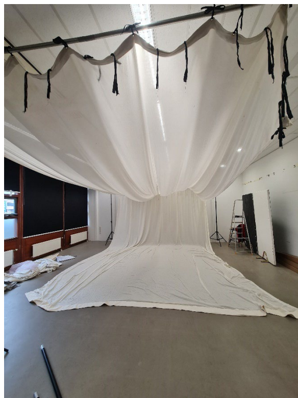
Imagem 57 - 2ª fase da construção do set
