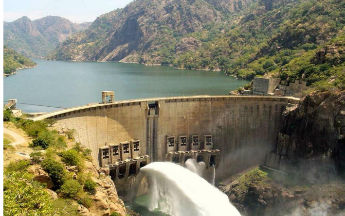
Figura 3: Central hidroelétrica de Cahora Bassa [4]
