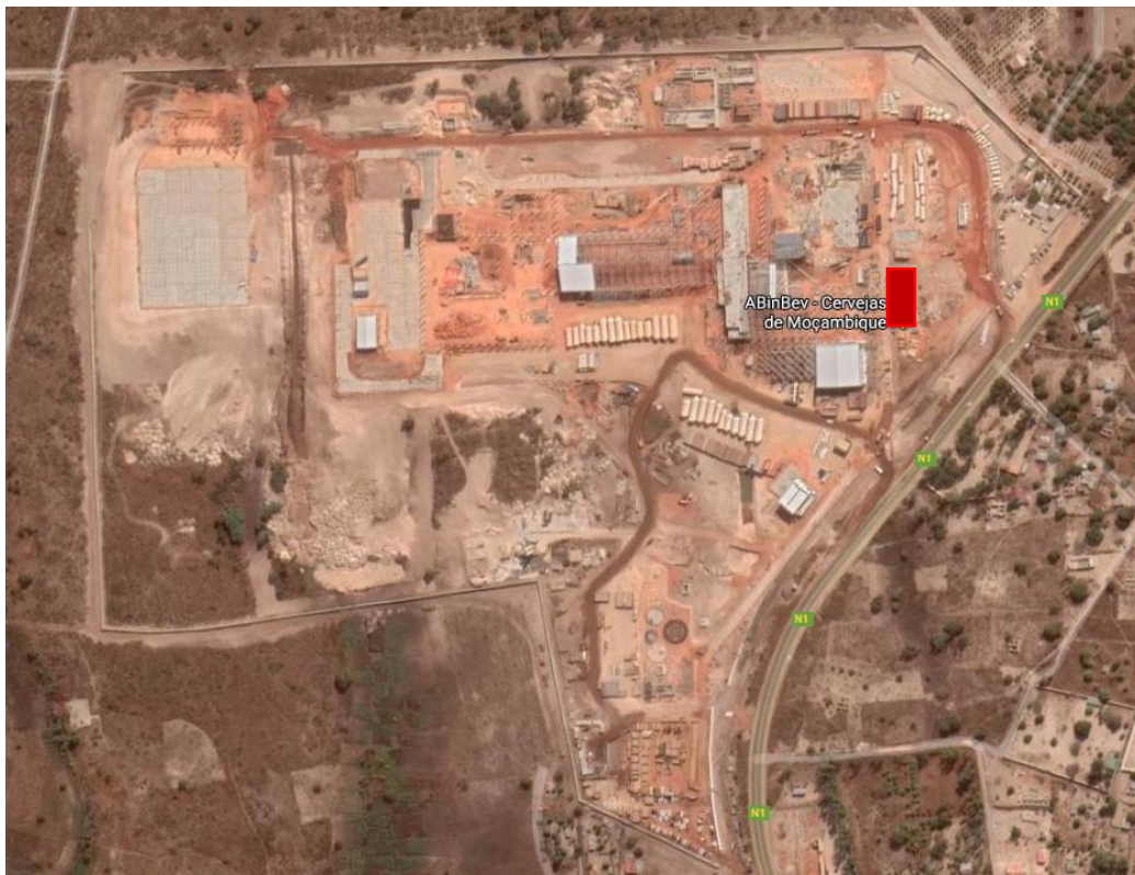
Figura 48: Área prevista para a instalação da subestação
