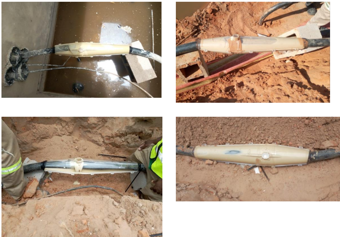
Figura 94. Processo de reparação de cabo de média tensão
