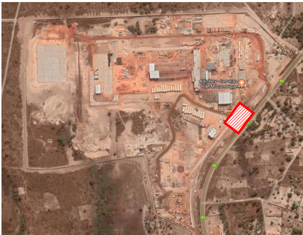
Figura 46: Área prevista para a instalação da central de Autoprodução
