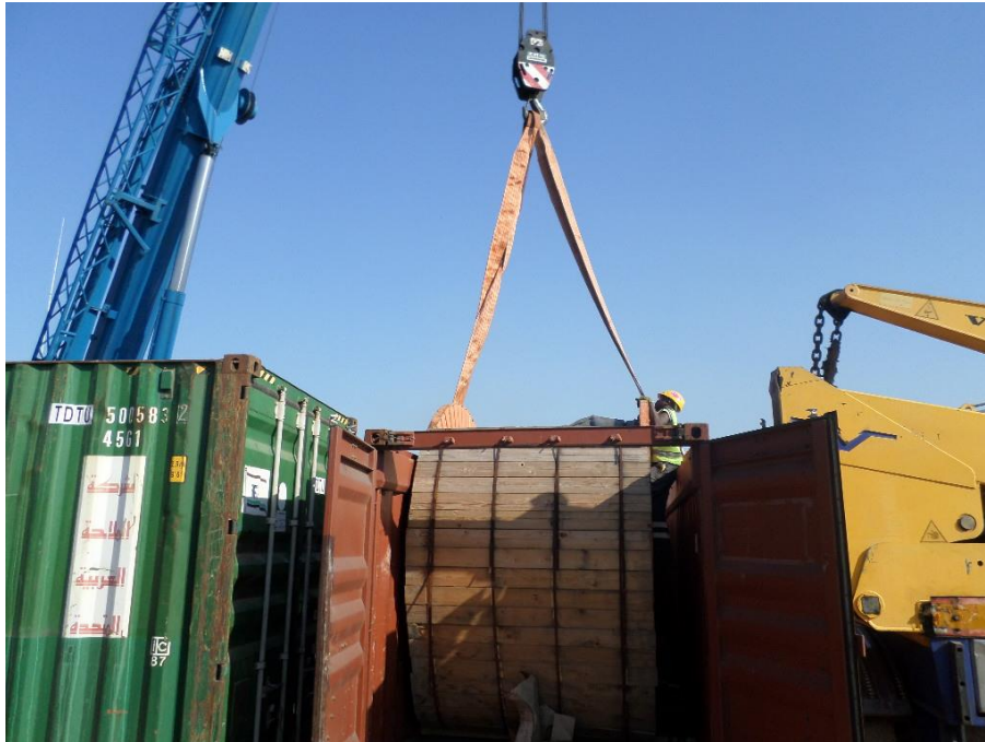
Figura 85: Transporte de cabo de média tensão do anel 2
