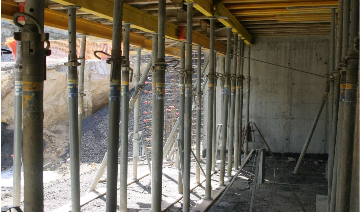
Figura 3.9 – Escoramento da laje do piso 0
