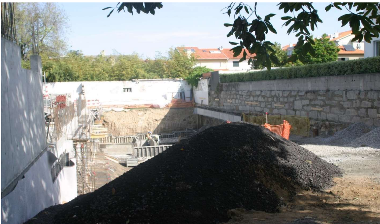
Figura 3.7 – Rampa de acesso às garagens
