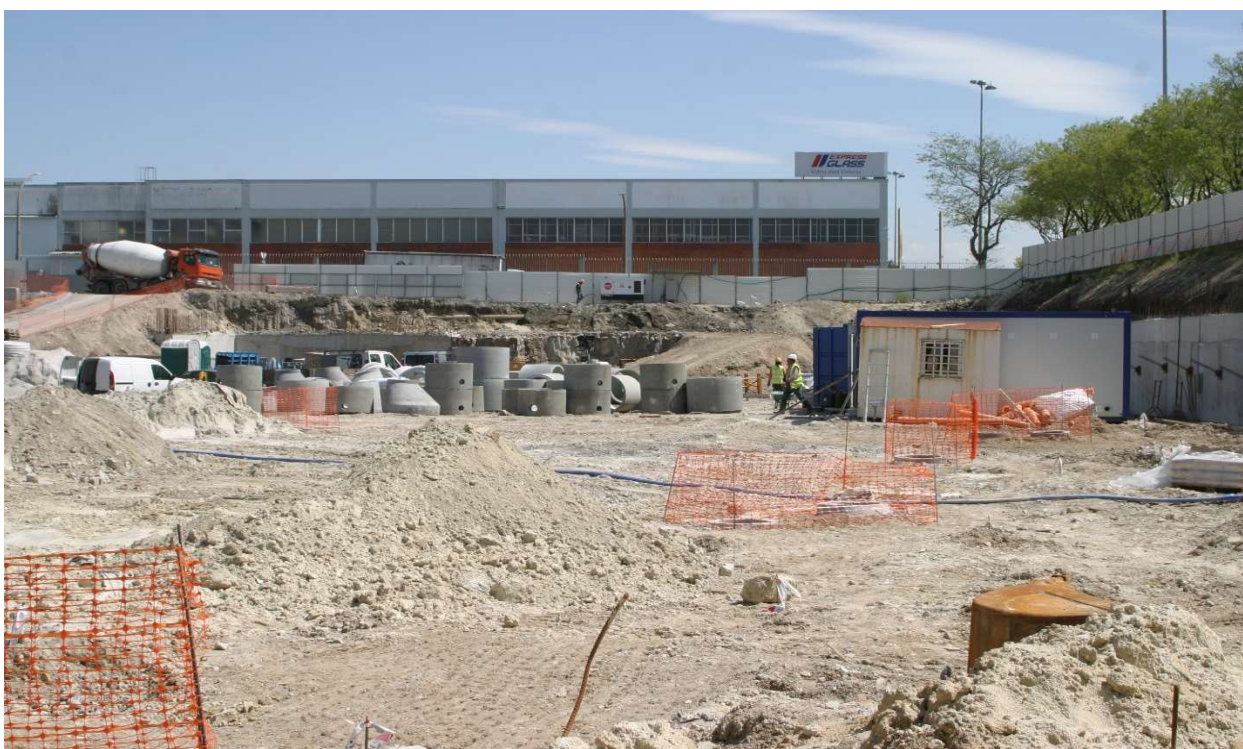
Figura 3.36 – Contentores de ferramentaria e entradas do estaleiro
