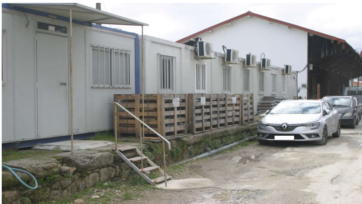
Figura 3.26 – Escritórios do estaleiro principal
