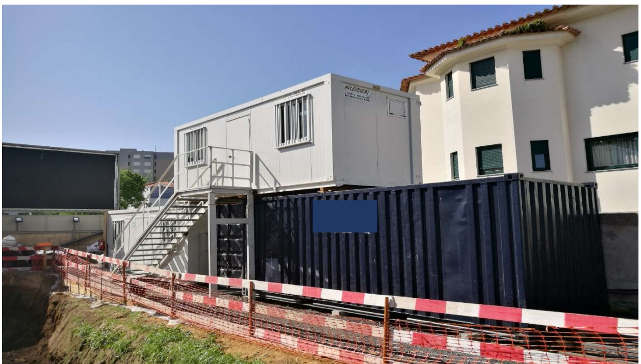
Figura 3.14 – Escritórios / Ferramentaria / Zona social
