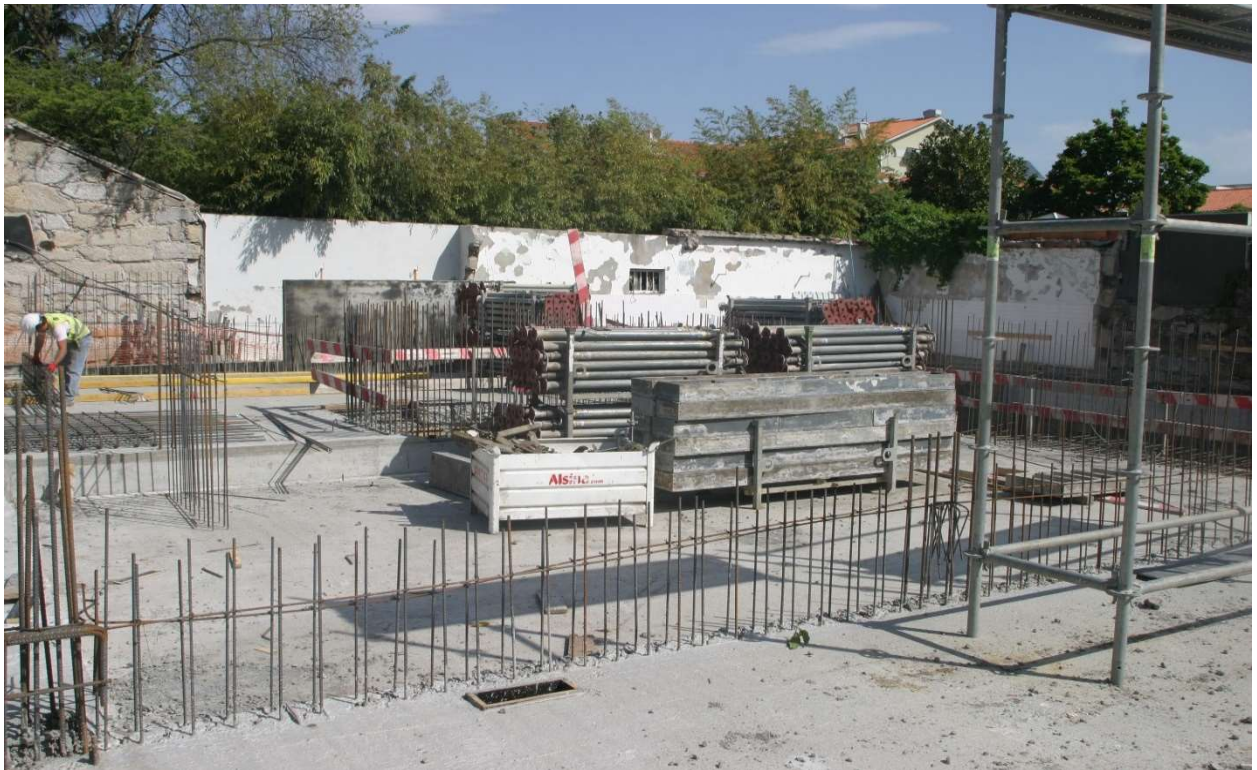
Figura 3.10 – Armazenamento de escoras
