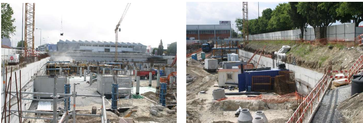
Figura 3.40 – Localização e ancoragem das gruas
