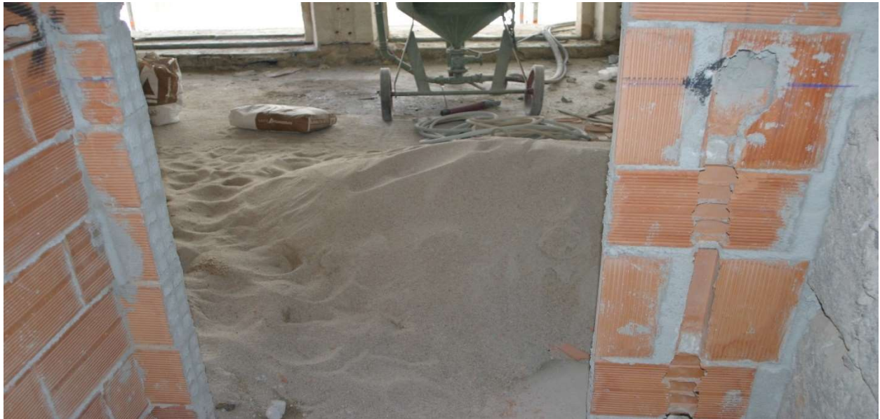
Figura 3.20 – Zona de fabrico de argamassas para reboco
