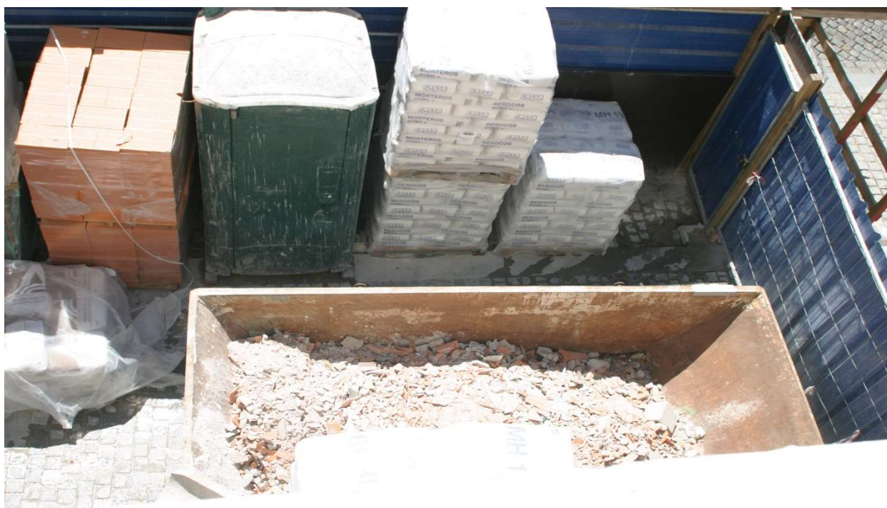
Figura 3.19 – Depósito de materiais no exterior
