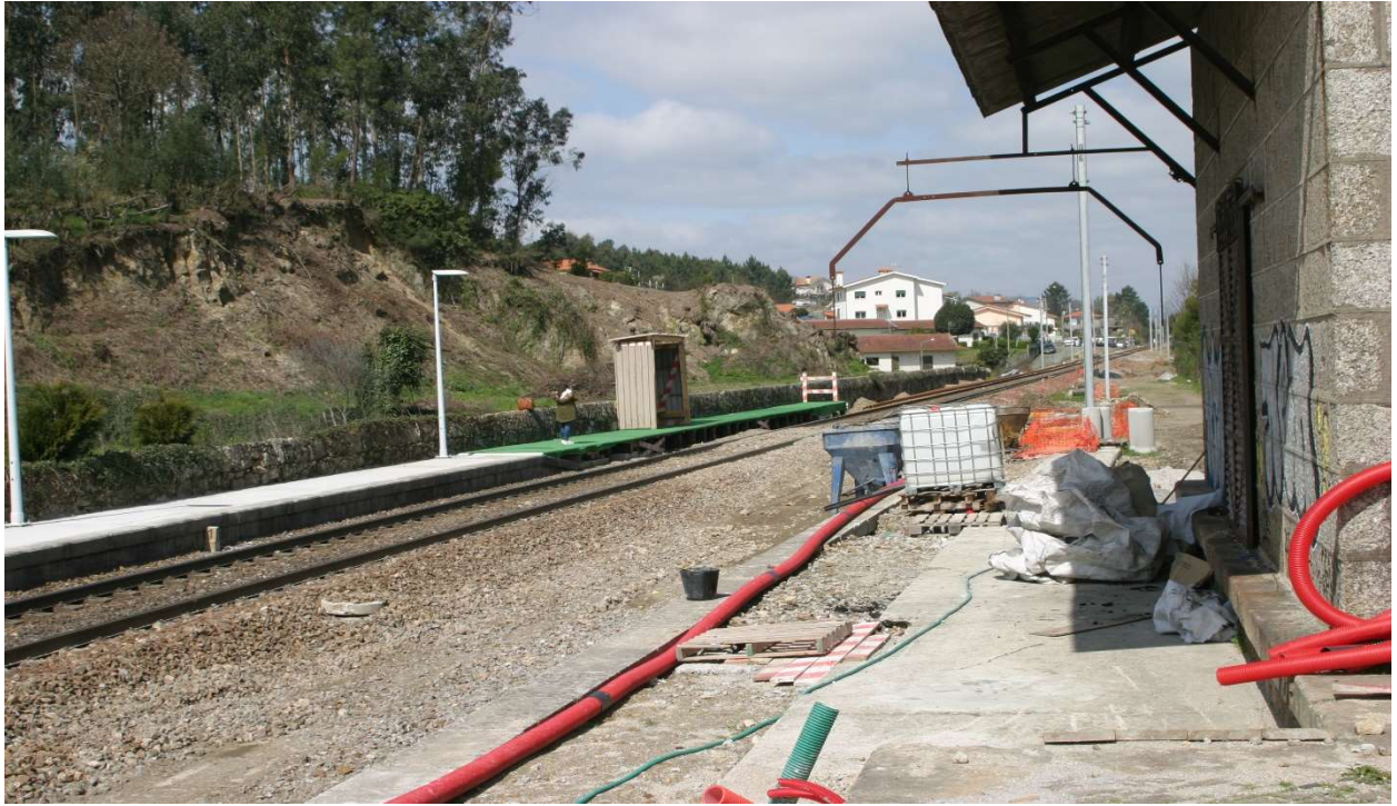
Figura 3.31 – Vista parcial de uma estação intervencionada
