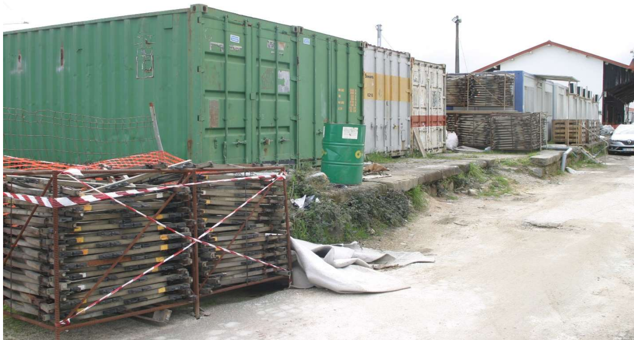
Figura 3.25 – Contentores de armazenamento dos equipamentos dos subempreiteiros
