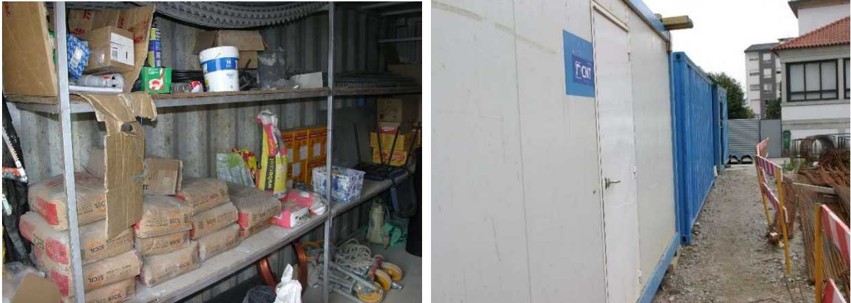
Figura 4.10 – Armazém de materiais
