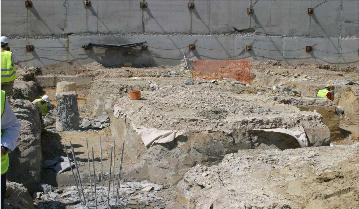
Figura 3.37 – Remoção da cabeça das estacas
