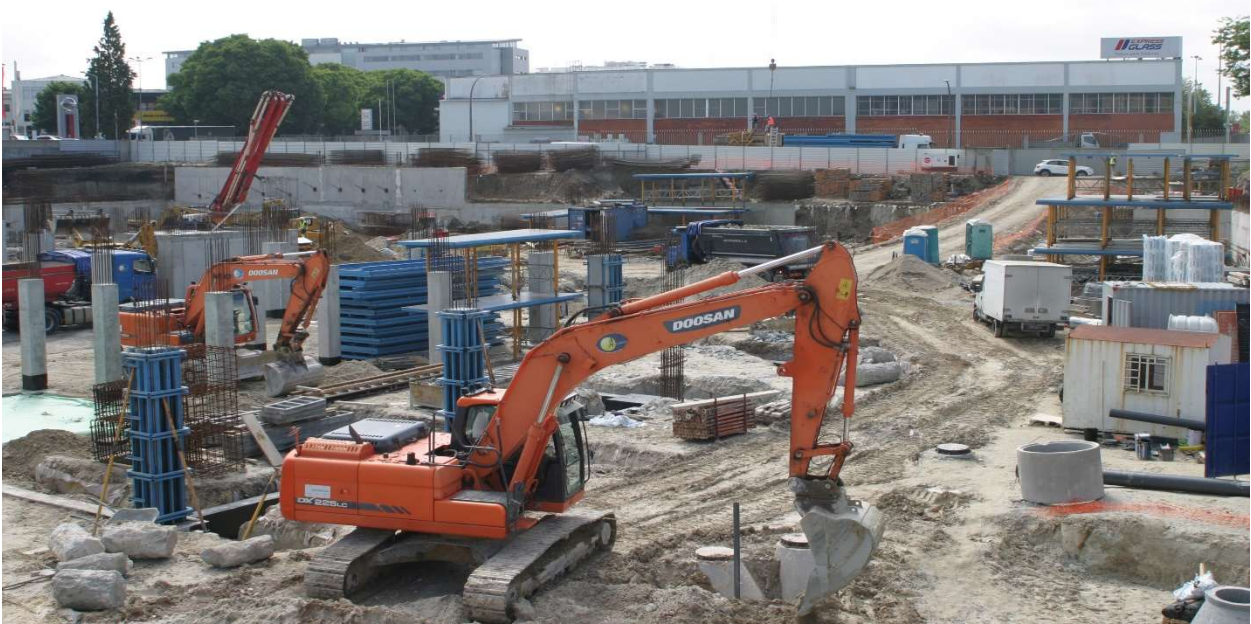
Figura 3.41 – Vista parcial do estaleiro / Rampa de acesso
