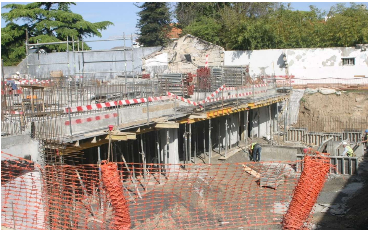
Figura 3.8 – Vista lateral de acesso às garagens (piso -1)
