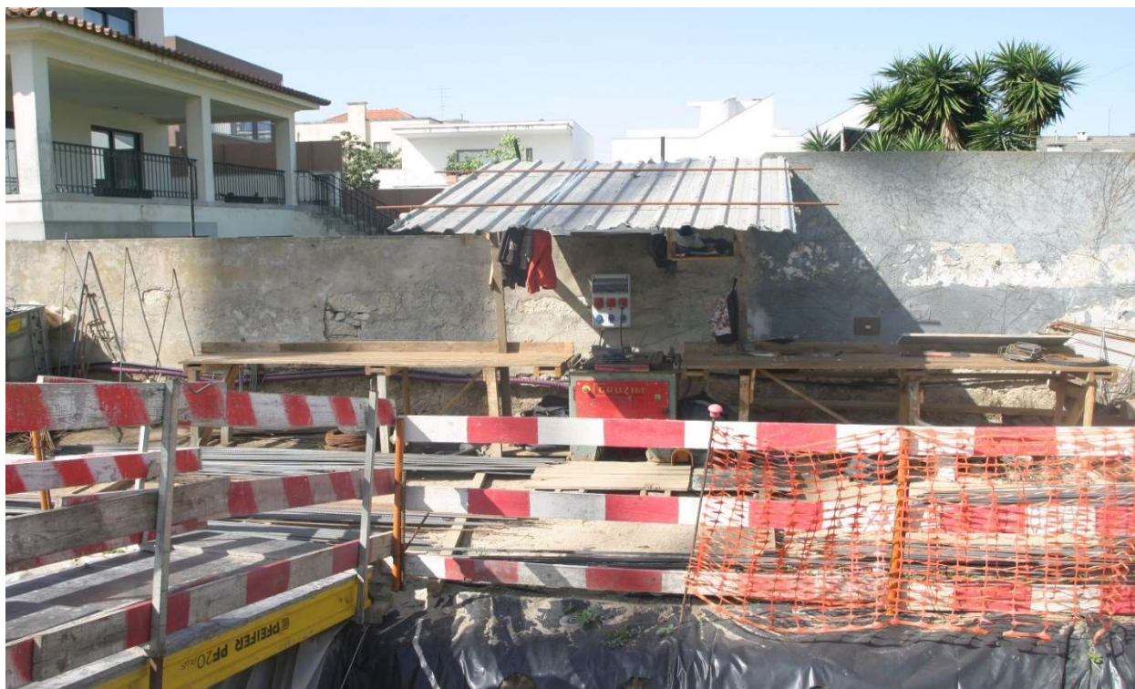
Figura 3.11 – Zona de fabrico de armaduras
