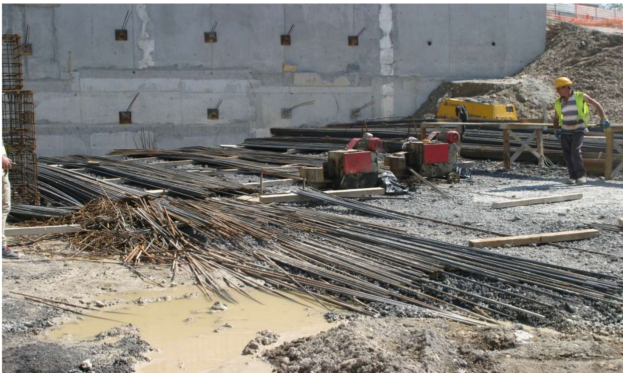
Figura 3.39 – Zona de fabrico de armaduras e depósito de varões
