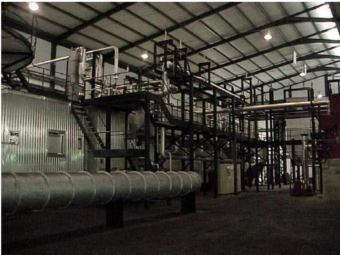
Figura 22 Instalação da caldeira (arquivo da empresa).
