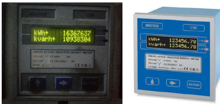
Figura 47 Contador de energia elétrica para a UVEP (foto da instalação e imagem de catálogo).
