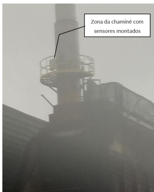
Figura 44 Zona de instalação de sensores na chaminé.
