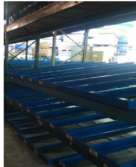
Figura 27 - Armazém de componentes com evidência de espaços vazios.
