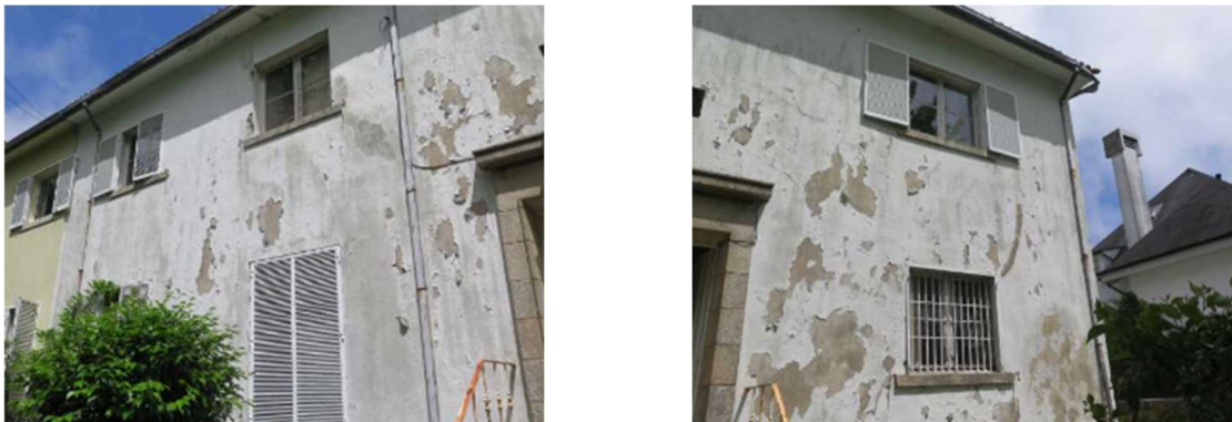
Figura 3.11 - Fachada frontal do edifício 6
