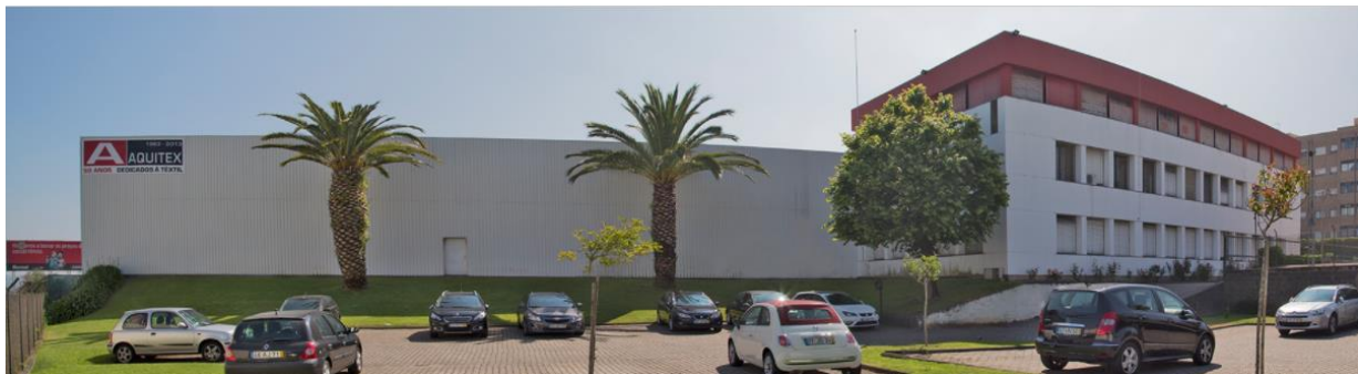
Figura 1.1- Instalações da AQUITEX S.A. em Pedrouços, Maia.
