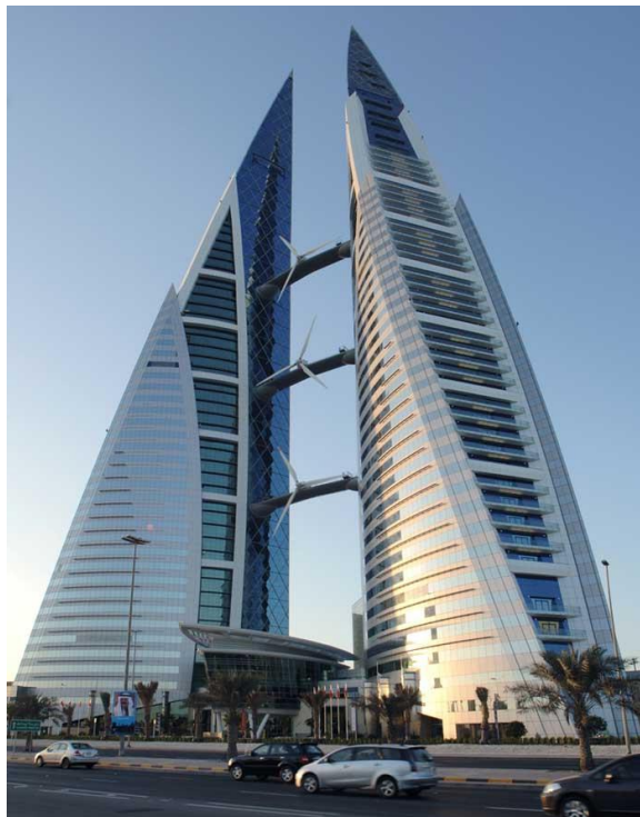
Figura 6.1 – Edifício Bahrain World Trade Center com energia renovável para suprir parte das suas necessidades energéticas [64].
