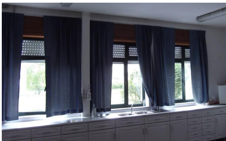
Figura 7.6 – Envidraçados e respetiva proteção solar interior com cortinas.
