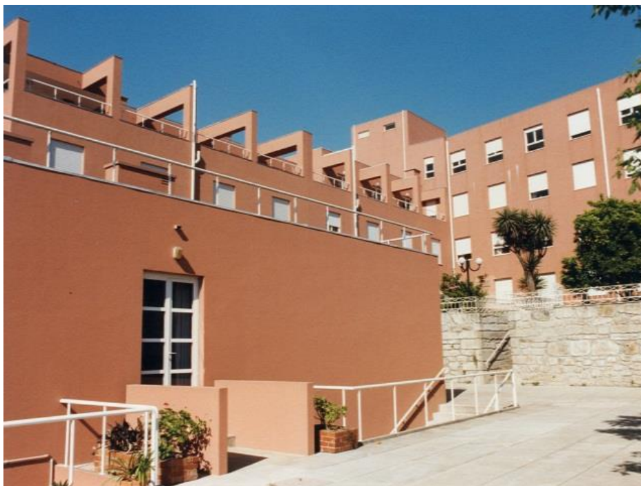
Figura 7.57 – Aspeto exterior do Lar “B”.
