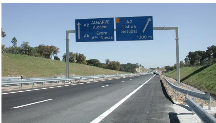
Figura 1.2 – Exemplo de pórtico de sinalização vertical
