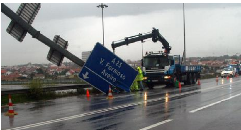
Figura 1.3 – Queda de pórtico devido a embate de camião
