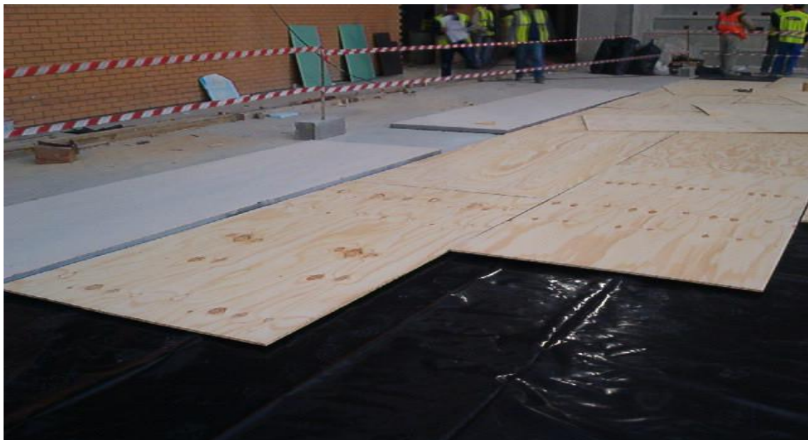
Figura 5.4 – Início da impermeabilização e colocação de aglomerado
