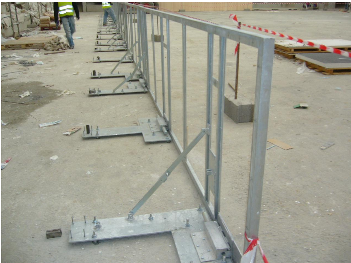
Figura 5.1 – Instalação em obra das estruturas metálicas
