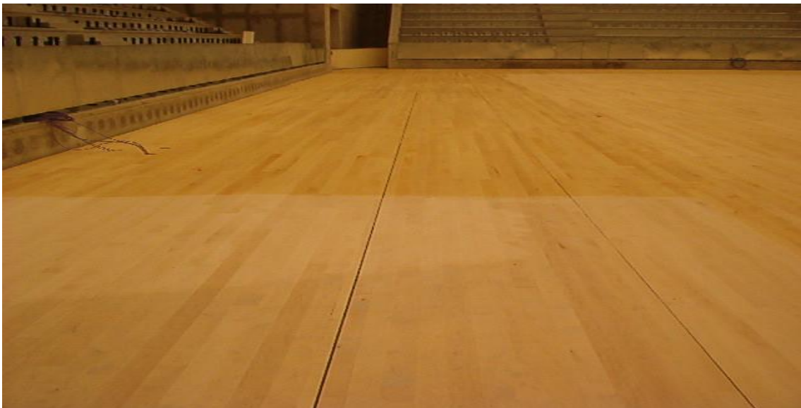
Figura 5.10 – Início do envernizamento, 1ª de mão
