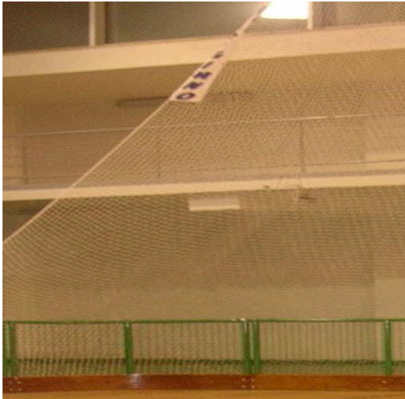
Figura 2.4 - Exemplo da Fixação de Rede de Protecção
