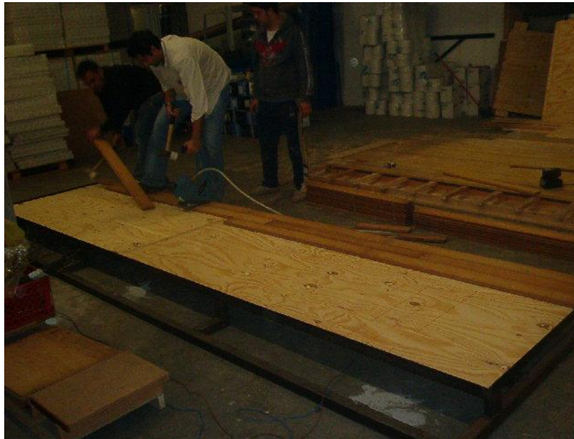
Figura 3.23 – PF, início da colocação do soalho
