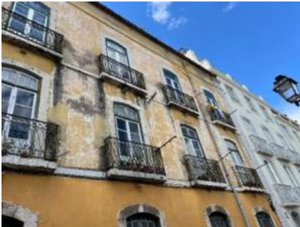
a) Fachada do edifício
