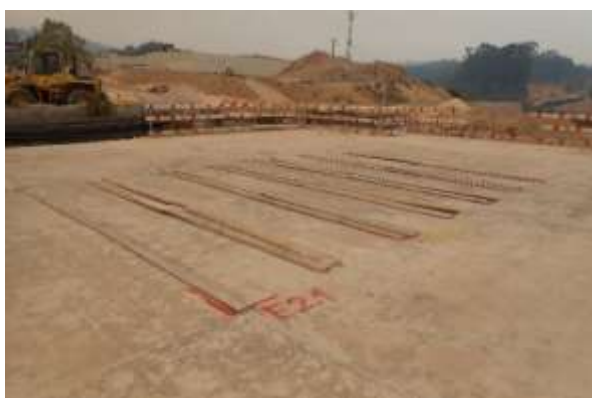
c) Marcação prévia na laje do ensaio
