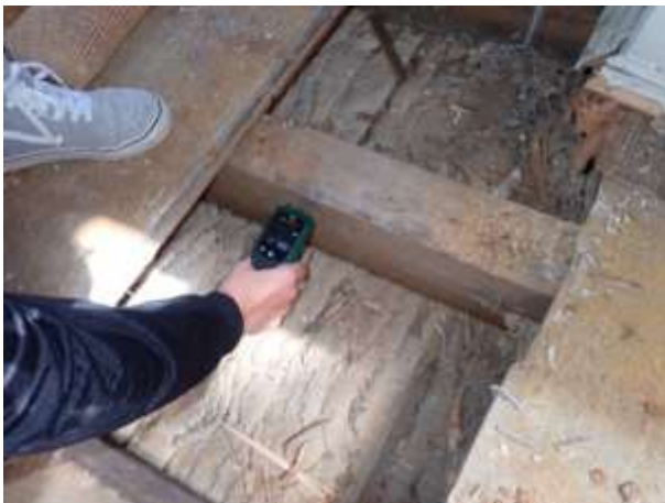
c) Medição do teor de humidade da viga de pavimento
