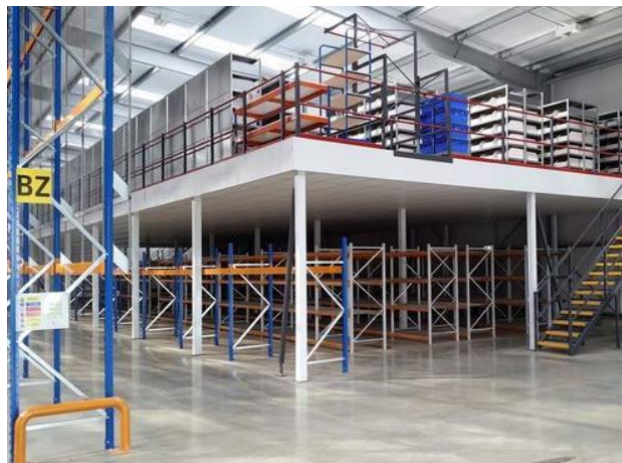
Figura 27 - Exemplo Layout Mezzanine.
