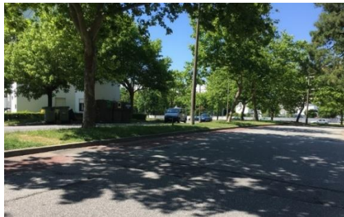
Figura 4.34 – Ponto 14: Pavimento desgastado, necessidade de reforço da pintura.
