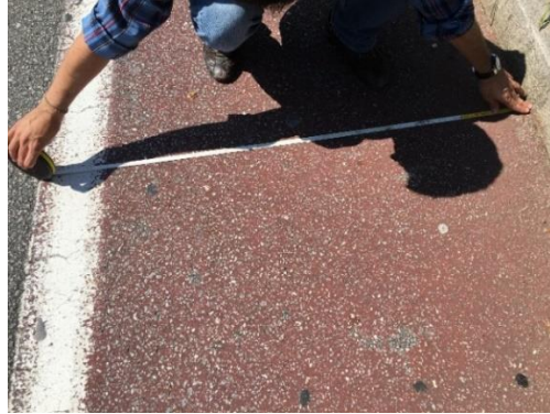
Figura 4.36 – Ponto 16: Ciclovia estreita com largura de aproximadamente 1,30m de cada lado.
