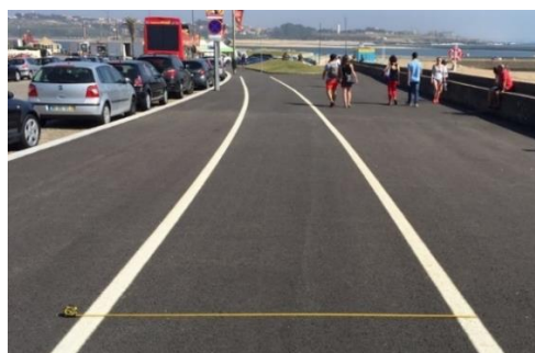
Figura 4.56 – Ponto 28: A largura da ciclovia passa a ser 2,38m, sendo depois possível visualizar o fim da marcação.
