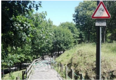
Figura 4.24 – Ponto 4: Advertência ao perigo de deslizamento e aviso de buraco em manutenção.
