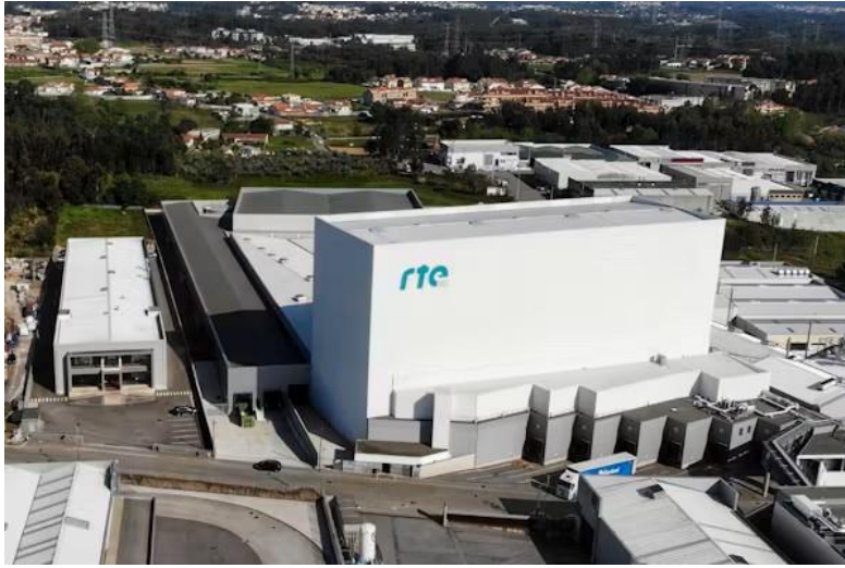
Figura 1 RTE, SA Unidade Fabril em Portugal
