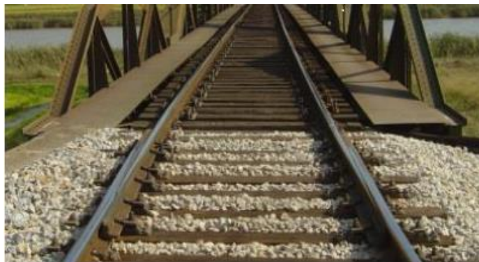
Fig. 4.17 - Aparelho de dilatação unidirecional (Gonçalves, 2014)
