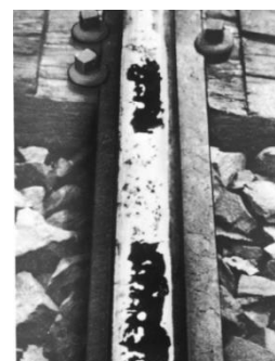
Fig 4.29 - Descascamento da superfície do carril (Couto, 2008)
