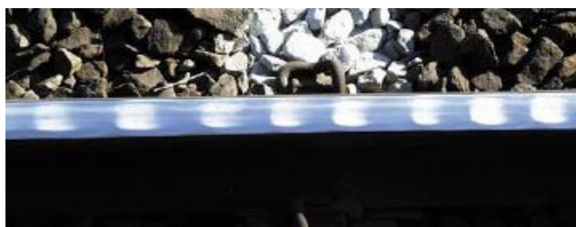
Fig. 4.27 - Ondulação da mesa de rolamento (Sousa, 2015)
