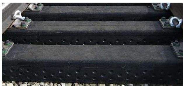
Fig. 4.11 - Travessas de material compósito (Oliveira, 2012)
