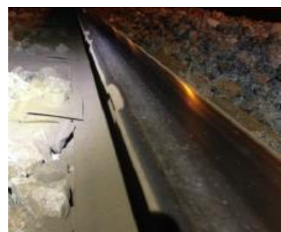
Fig. 4.25 - Esmagamento da face interior do carril (Mourão, 2017)
