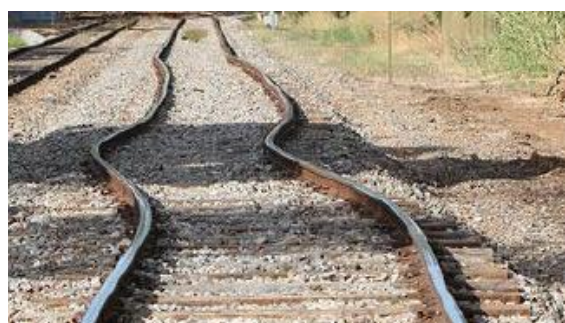
Fig. 9.15 - Deslocamento transversal da via (Rodrigues, 2012)
