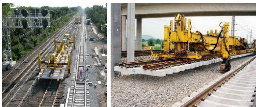
Fig. 9.16 - Substituição integral da via (Rodrigues, 2012)
