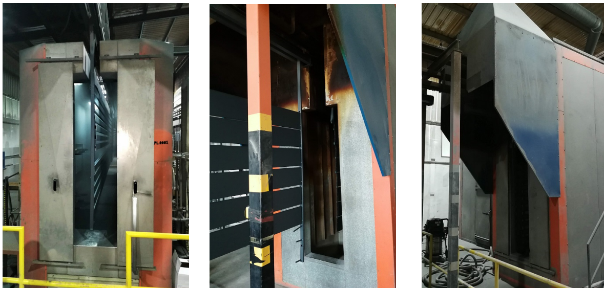
Figura 4.9: Linha da Lacagem: à direita, a câmara de pintura de perfis; ao centro e à esquerda, o forno de polimerização.
