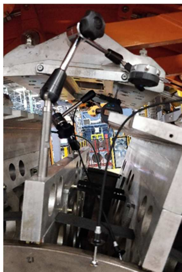
Figura 35 - Montagem de equipamentos de medição de concentricidade e paralelismo entre BTR e BM (depois)
