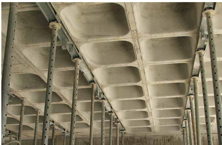
Figura 3.3 - Sistema de cofragem recuperável plana - Fonte: Samicofra.com
