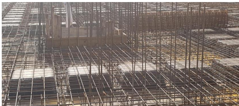
Figura 1.3 - Construção de laje fungiforme - fonte: FORMA Z.
