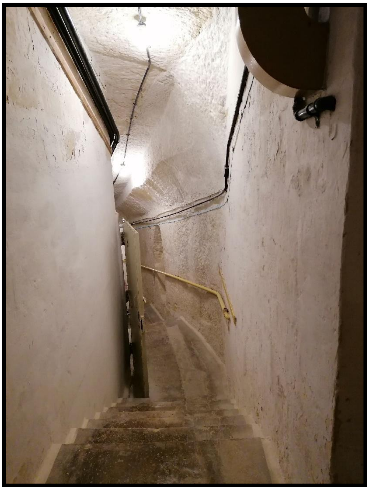
Fig. 330 Túneis de acesso para a Sala de Operações (São os novos túneis que tiveram de fazer durante a 2ª Guerra Mundial).
