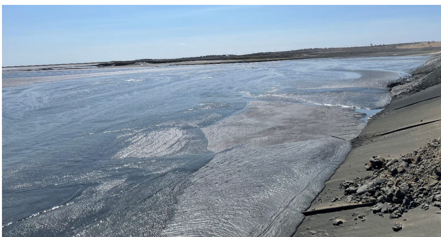
Figura 43. Deposição de rejeitado espessado
