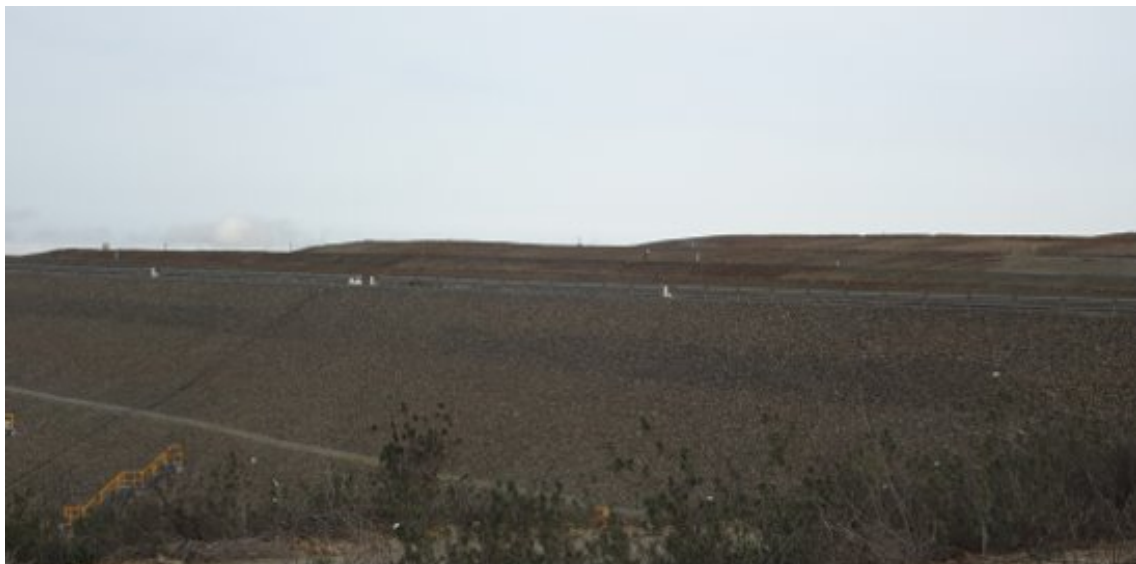
Figura 48. Vista do empilhamento vertical a montante da portela da margem esquerda da Barragem de rejeitados
