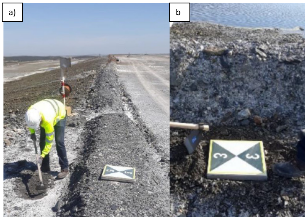
Figura 56. Alvos topográficos de monitorização de assentamento das coberturas a)preparação ligeira do terreno; b) marca instalada
