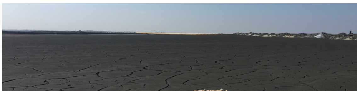
Figura 35. Superfície de Rejeitado espessado depositado em secagem
