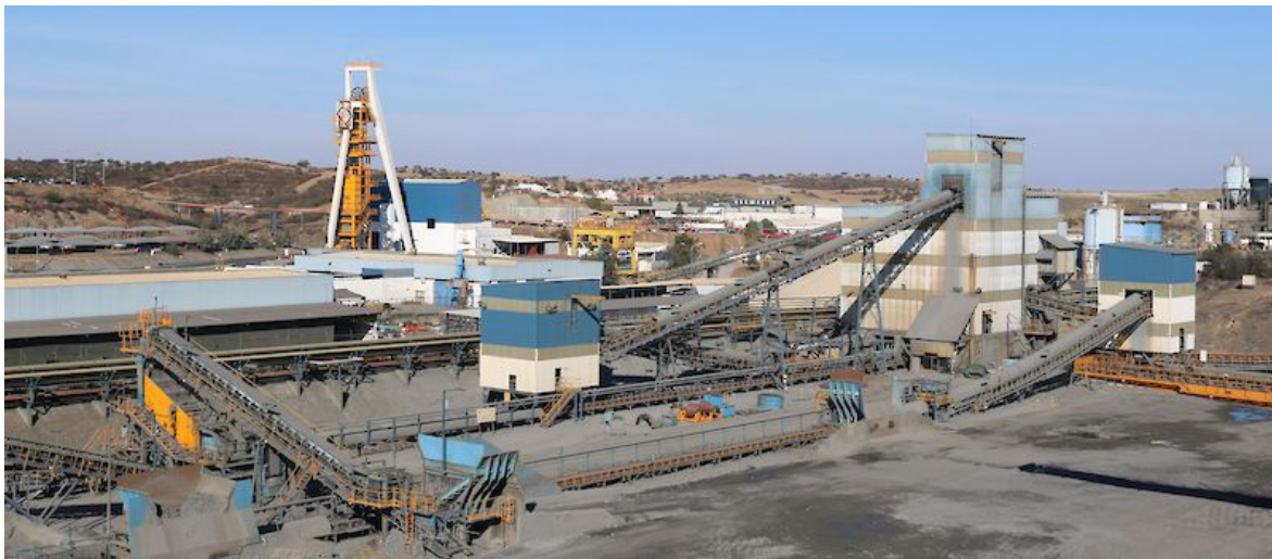
Figura 26. Vista da área industrial de Neves-Corvo: parque de minério e Poço de extração de Santa Bárbara ao fundo
