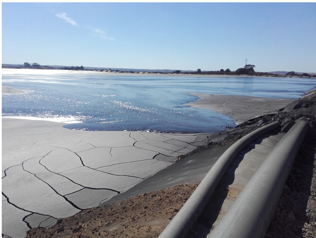
Figura 55. Tubagens de deposição de rejeitados espessados a partir de berma perimetral
