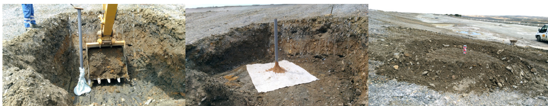
Figura 59. Indicadores de Nível de Água em construção
