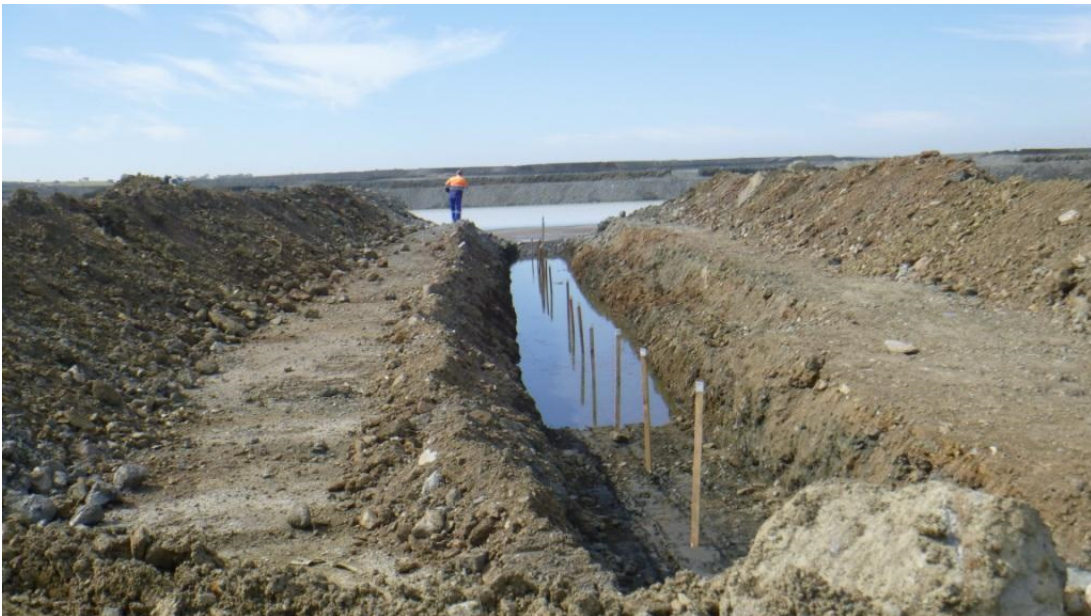
Figura 62. Trincheira de prospeção na cobertura de escombro
