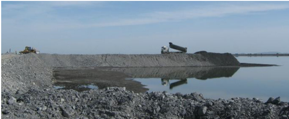
Figura 45. Construção de Diques
