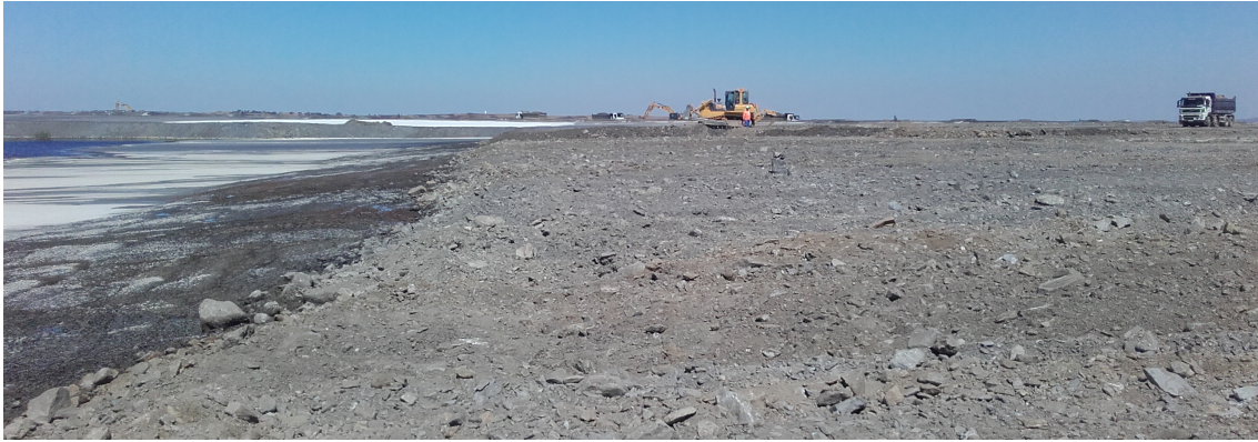
Figura 51. Construção camada de escombros sobre rejeitados espessados
