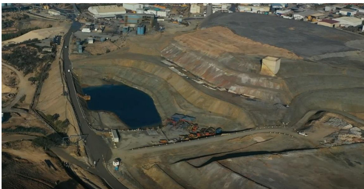
Figura 36. Escombreira com barragem de águas contaminadas a Jusante
