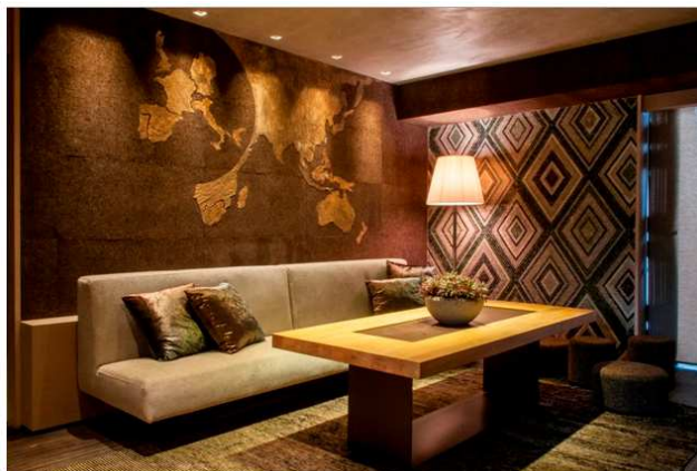
Figura 36 – Espaço com aplicação à vista de aglomerado negro de cortiça no paramento vertical interior, conferindo conforto quer a nível acústico quer a nível visual [53]
