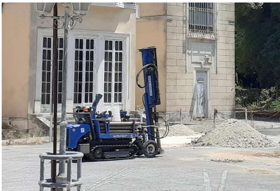
Figura 58 - Equipamento de furação, Dando Terrier (cortesia: Mota-Engil).
