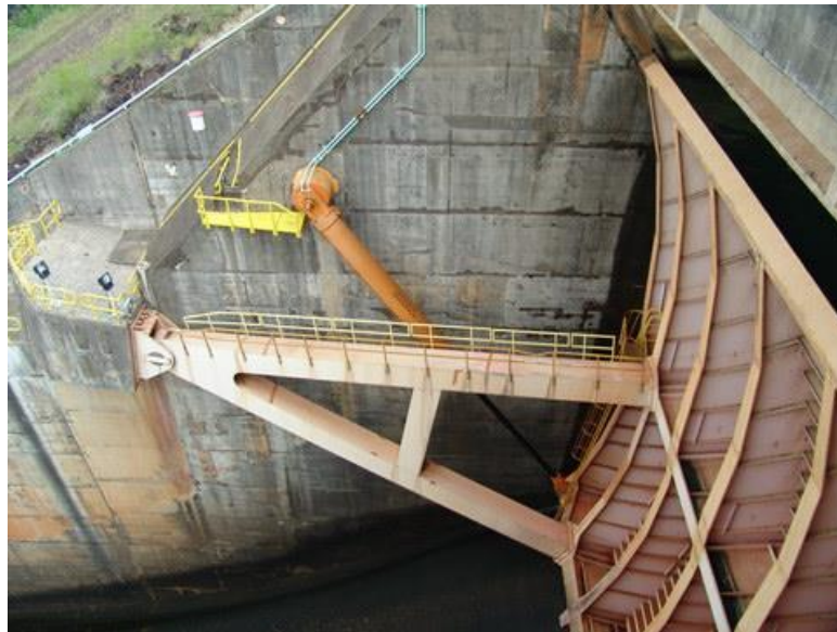
Figura 19 – Atuador hidráulico (cilindro) para abertura de comporta [37]
