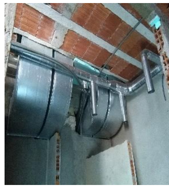
g) Colocação das tubagens para AVAC e extração de ar
