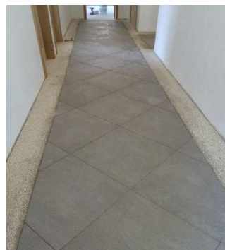
b) colocação de tijoleira
