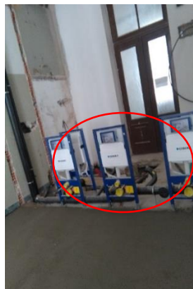
c) Colocação do material Geberit
