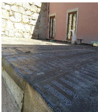
i) Colocação da tela de impermeabilização
