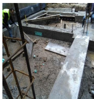
f) Sapatas e vigas já construídas
