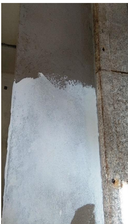
Figura 3.8 – Exemplo de aplicação de mecafino plus numa parede de casa de banho na obra “Empreitada de Museus da UP- Intervenção Parcial I”
