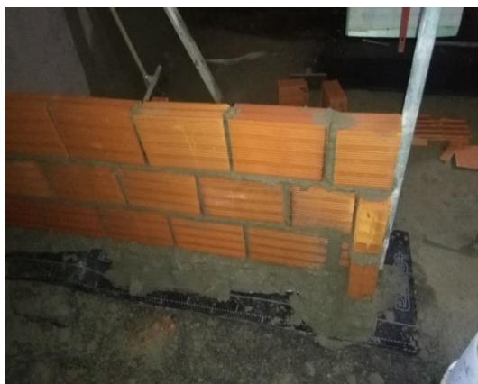
a) Aplicação de argamassa de assentamento no levantamento de paredes
