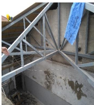
a) Colocação da estrutura metálica na cobertura
