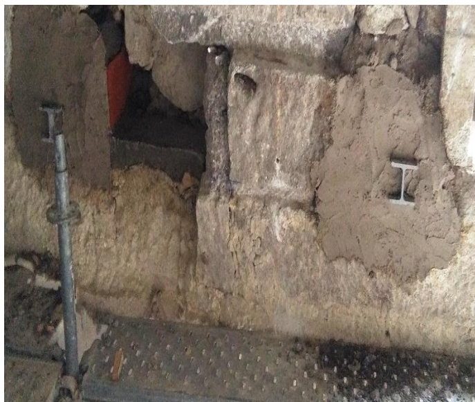
b) Aplicação de argamassa pré-fabricada para fixação de perfis metálicos na obra “Empreitada de Museus da UP- Intervenção Parcial I”
