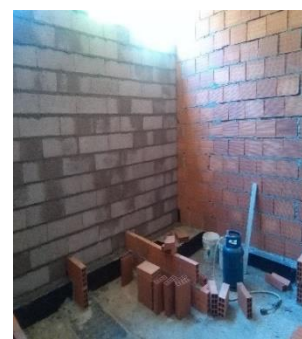
g) Iniciação da construção de algumas paredes interiores de blocos e de tijolos
