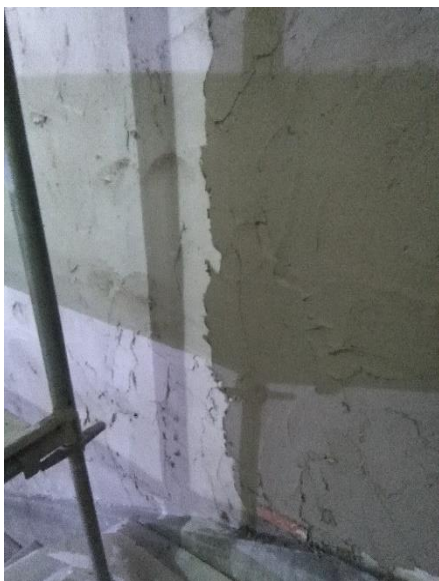
a) Aplicação de argamassa pré-fabricada em alvenarias na obra “Empreitada de Museus da UP- Intervenção Parcial I”
