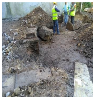
b) Abertura e escavação de valas para as sapatas e vigas
