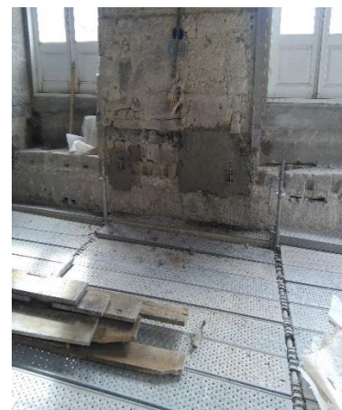
c) Cravação das chapas metálicas com argamassa pré-fabricada da Weber.cal Classic
