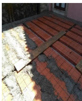
d) Colocação de argamassa de regularização na cobertura
