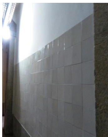
b) Colocação de azulejo
