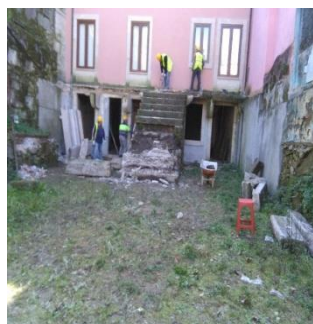
a) Demolição do alçado posterior à rua d. Manuel II
