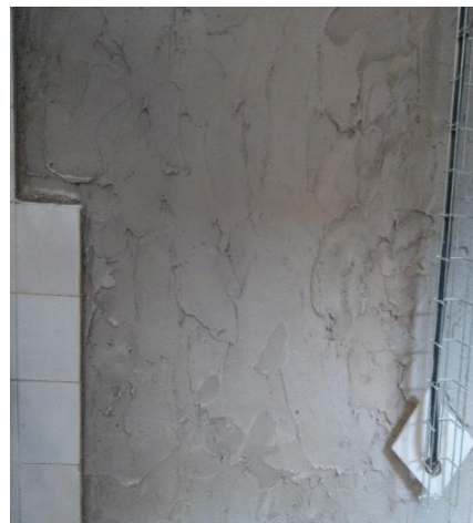
b) Depois de aplicação da argamassa
