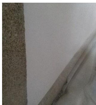
d) Pintura das paredes onde foi colocada argamassa pré-fabricada (1º de mão de cor branca)
