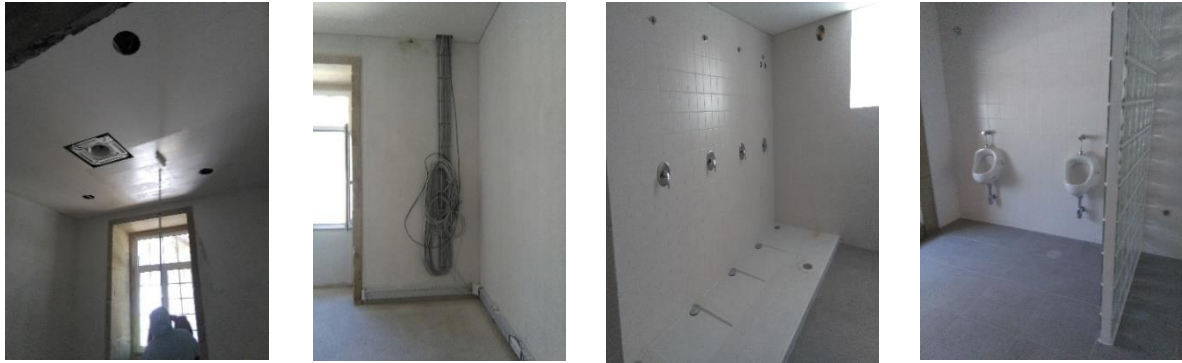
a) Pintura no pladur b) Acabamento da instalação elétrica c) Colocação de torneiras e chuveiros nos WC's d) Colocação de urinóis e lavatórios nos WC's
