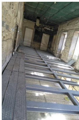
a) Colocação de toda a estrutura metálica no 4º piso
