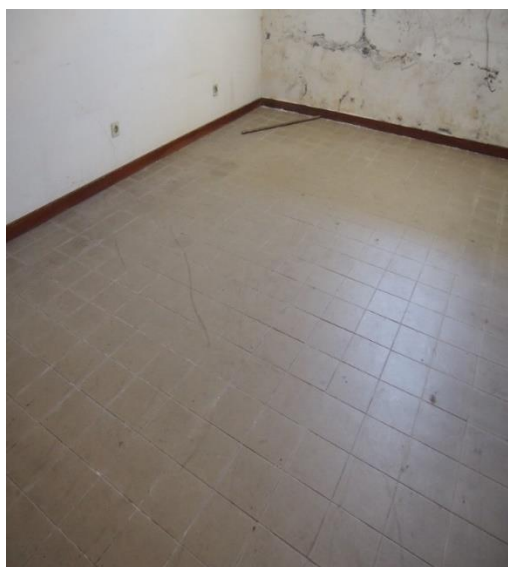
a) Pavimentos interiores antes da aplicação da argamassa de cimento
