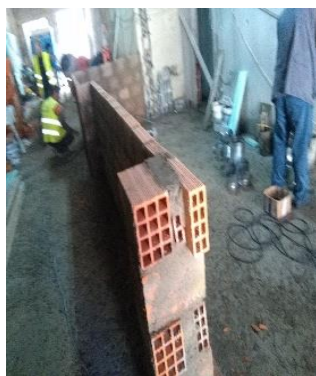
h) Execução do balcão da sala de refeições
