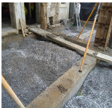
a) Colocação de brita para a realização do piso da ampliação
