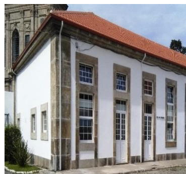
c) Pintura (cor branca) e colocação de toda a caixilharia
