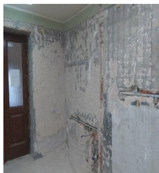
b) Demolição parcial da casa de banho do 2º piso
