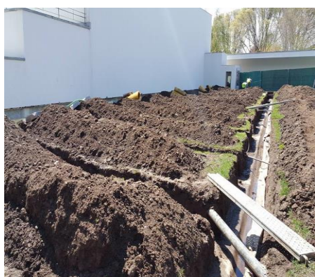
c) Colocação de novo sistema de drenagem
