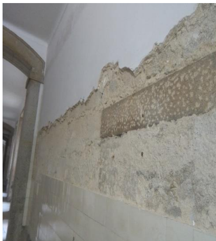
a) Antes da aplicação da argamassa
