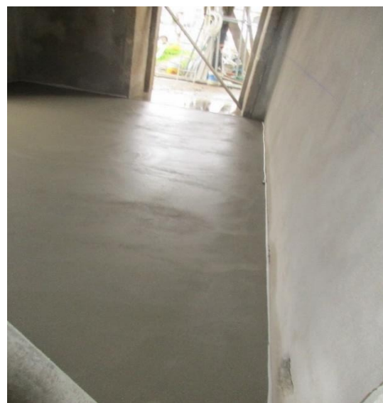
b) Pavimentos interiores depois da aplicação da argamassa cimento
