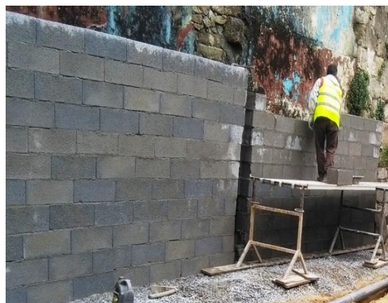
b) Aplicação de argamassa de assentamento no levantamento de muros
