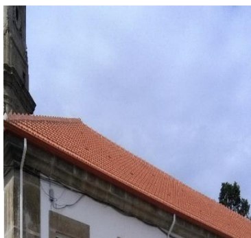
b) Cobertura finalizada
