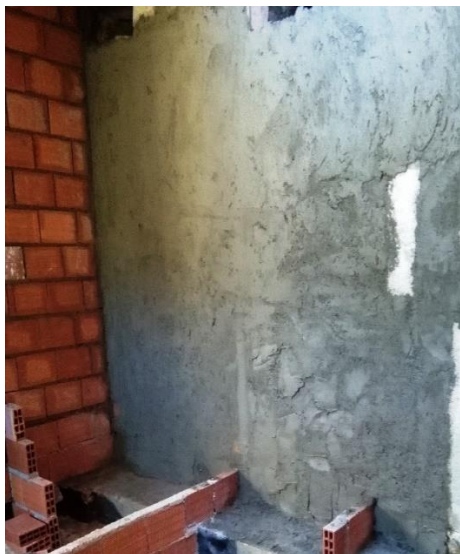
a) Emboço com argamassa de cimento na obra “Restaurante e take away”
