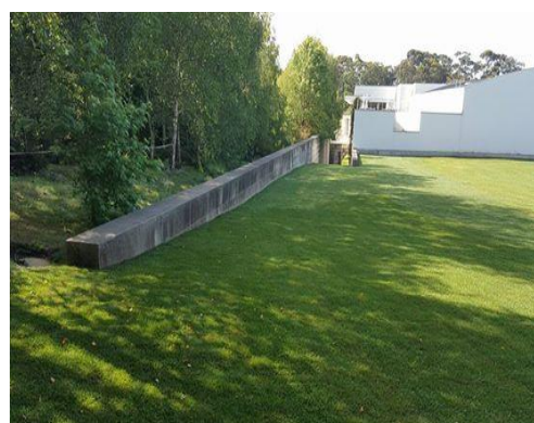
d) Fim da obra
