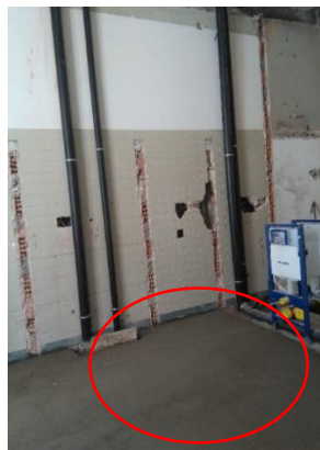
b) Execução do pavimento nas instalações sanitárias
