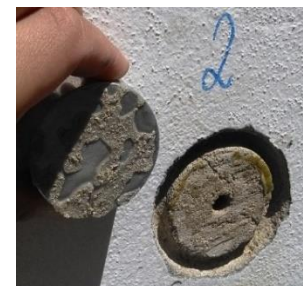
c) Resultado da peça metálica nº2
