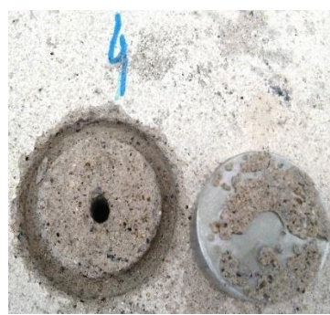
e) Resultado da peça metálica nº4
