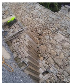
f) Execução de escadas exteriores para a plataforma superior
