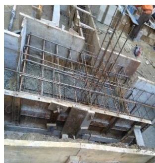
d) Execução das sapatas
