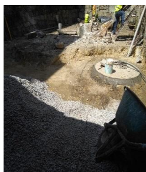
e) Rebaixamento do poço existente
