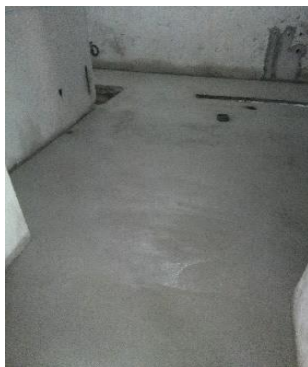
f) Nivelamento com argamassa de cimento do piso da cozinha
