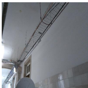
e) Aplicação da instalação elétrica no 1º piso
