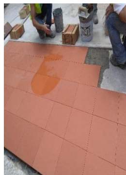
c) Colocação de tijoleira na cobertura
