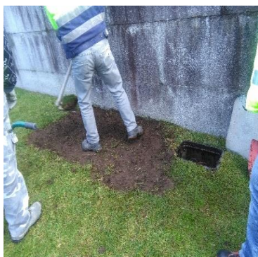
b) Começo da retirada da relva
