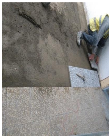
a) Colocação da tijoleira do corredor do 2º piso
