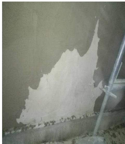
b) Emboço com argamassa pré-fabricada (weber.cal classic) na obra “Empreitada de Museus da UP- Intervenção Parcial I”
