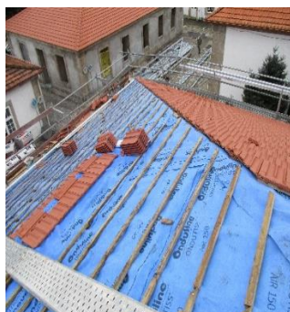
b) Colocação da telha e subtelha na cobertura
