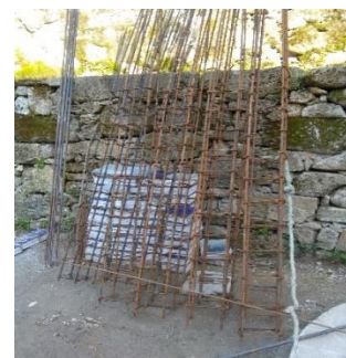
c) Amarração da armadura para as vigas e sapatas
