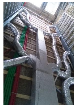
d) Colocação da tubagem do AVAC na sala do restaurante
