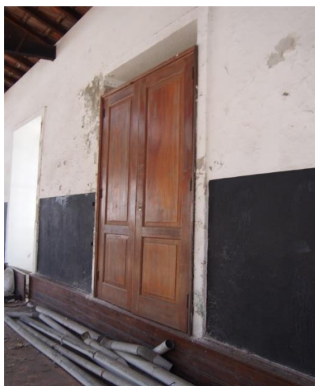
a) Paredes interiores antes da aplicação da argamassa de cal hidráulica
