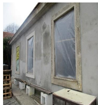
c) Vista exterior da obra no começo do estágio
