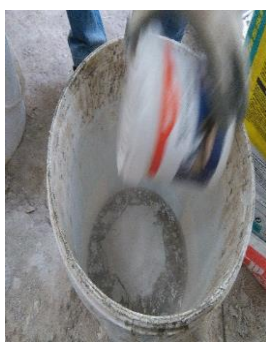
b) Colocação da argamassa do balde
