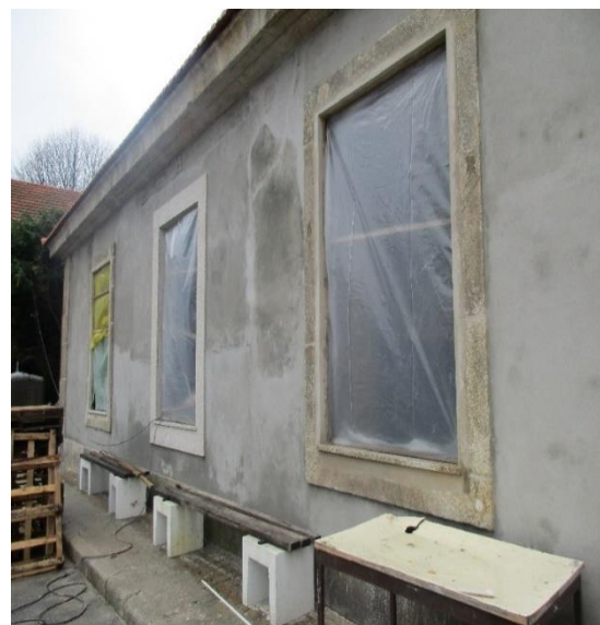
b) Paredes exteriores depois da aplicação da argamassa de cal hidráulica
