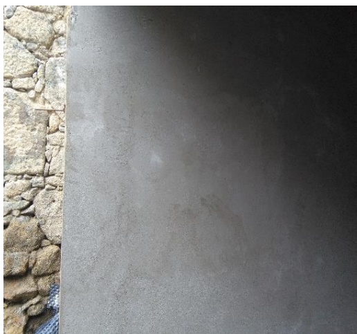
a) Reboco com argamassa de cimento na obra “Restaurante e take away”
