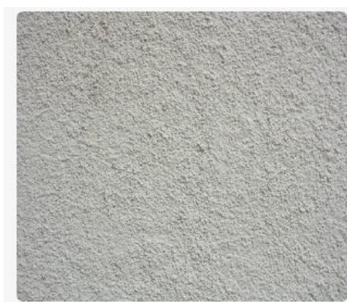
Figura 3.23 – Chapisco com pedra britada
