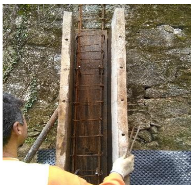
b) Colocação da armadura e cofragem em madeira para a betonagem dos pilares e vigas
