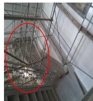
f) Lixagem das grandes e janelas interiores
