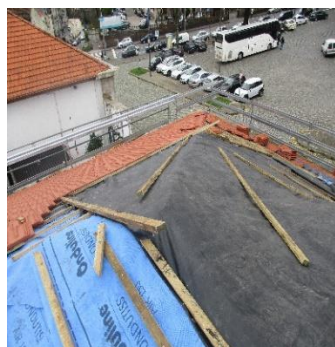
a) Finalização da colocação da telha na cobertura
