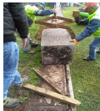
c) Retirada das pedras do Muro existente
