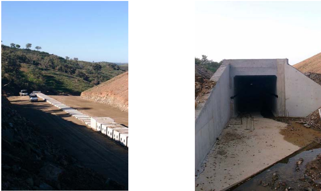
Figura 10.28 — Vista geral do local da obra e do acesso ao interior.
