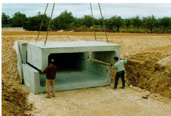
Figura 10.2 — Colocação dos elementos pré-fabricados.
