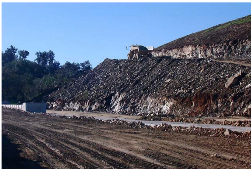
Figura 10.18 — Vista geral do local da obra.
