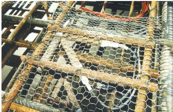
Figura 5.22 — Aplicação em obra de uma roseta de extensómetros.
