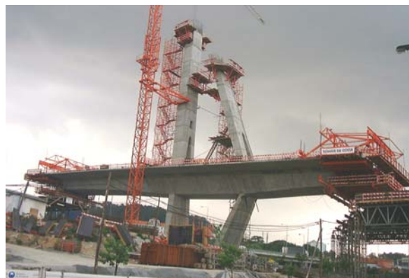
b) Viaduto sobre a VCI, no Porto.
