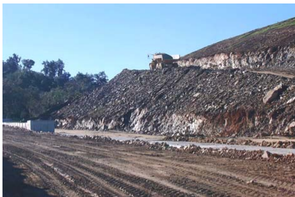
a) Box-Culvert em Almodôvar;
