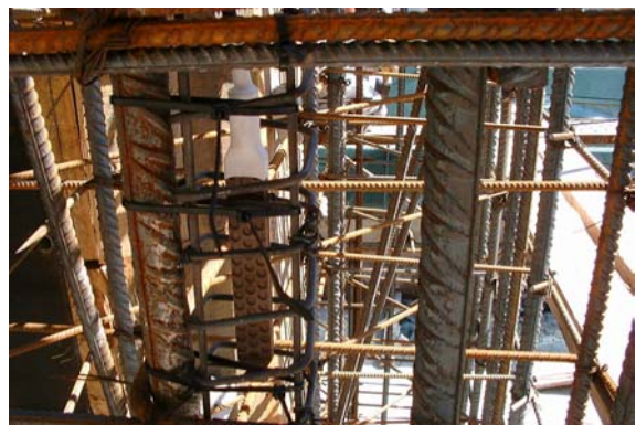
b) Pormenor da instalação de um extensómetro
