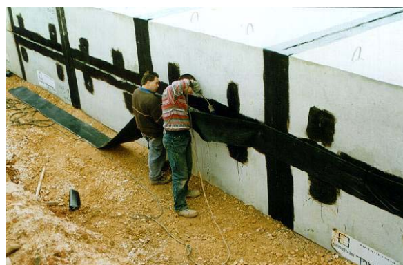
Figura 10.3 — Selagem das juntas com tela asfáltica.
