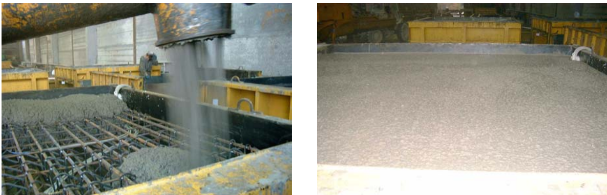
Figura 10.26 — Box-Culvert durante e após a betonagem.
