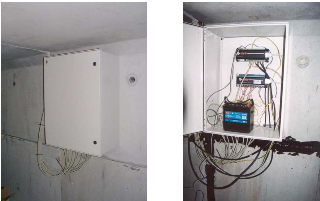
Figura 10.32 — Posto de observação instalado no interior da box-culvert.
