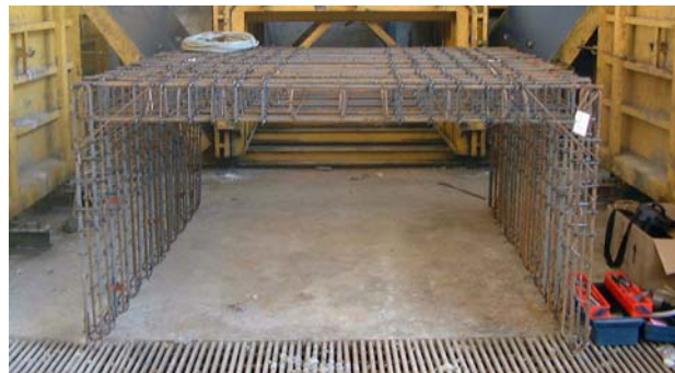
Figura 10.22 — Armadura do elemento a instrumentar.
