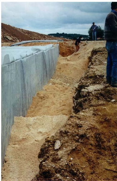
Figura 10.5 — Colocação do material de aterro na zona lateral da estrutura.
