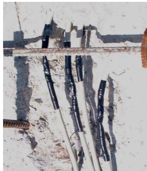
b) Após a reparação
