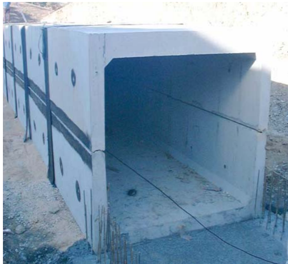
Figura 10.20 — Elementos instalados em obra.
