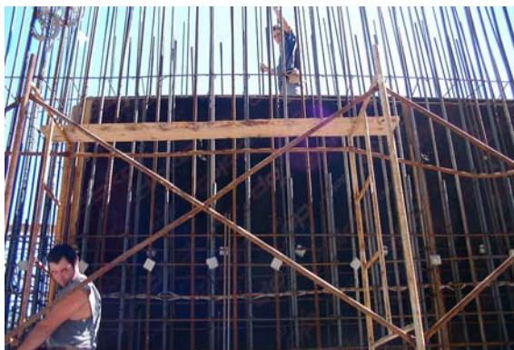
a) Armadura do PP2 sem cofragem exterior
