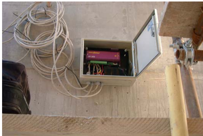
Figura 10.52 — Posto de observação provisório na base do pilar provisório PP2.
