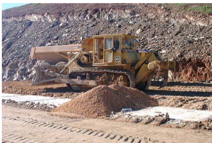
Figura 10.30 — Camada de aterro colocada sobre as células de pressão.
