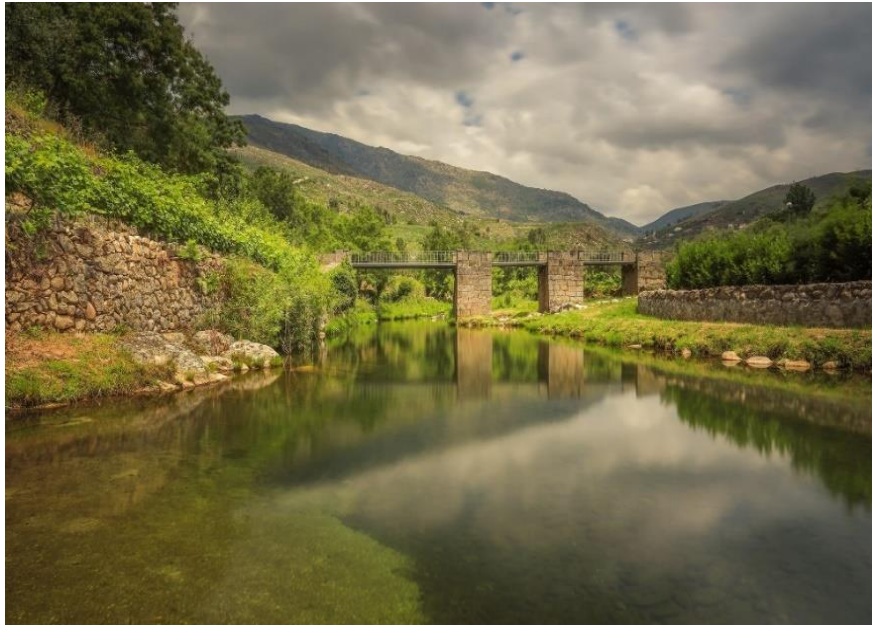
Figure 35 Poço da Ponte Velha at Cortes do Meio (Ribeiro, 2021).
