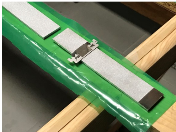
Figura 50 - Montagem do conjunto de calços
