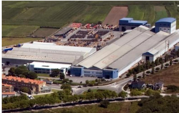
Figura 2 - Instalações da Solidal - Condutores Elétricos, S. A.
