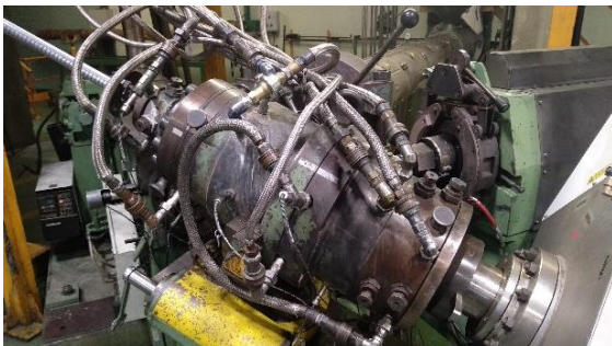
Figura 24 - Estado inicial das mangueiras de aquecimento da cabeça de extrusão
