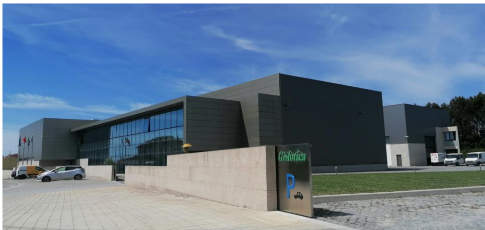
Figura 1 Empresa Gislottica – vista exterior das instalações fabris.
