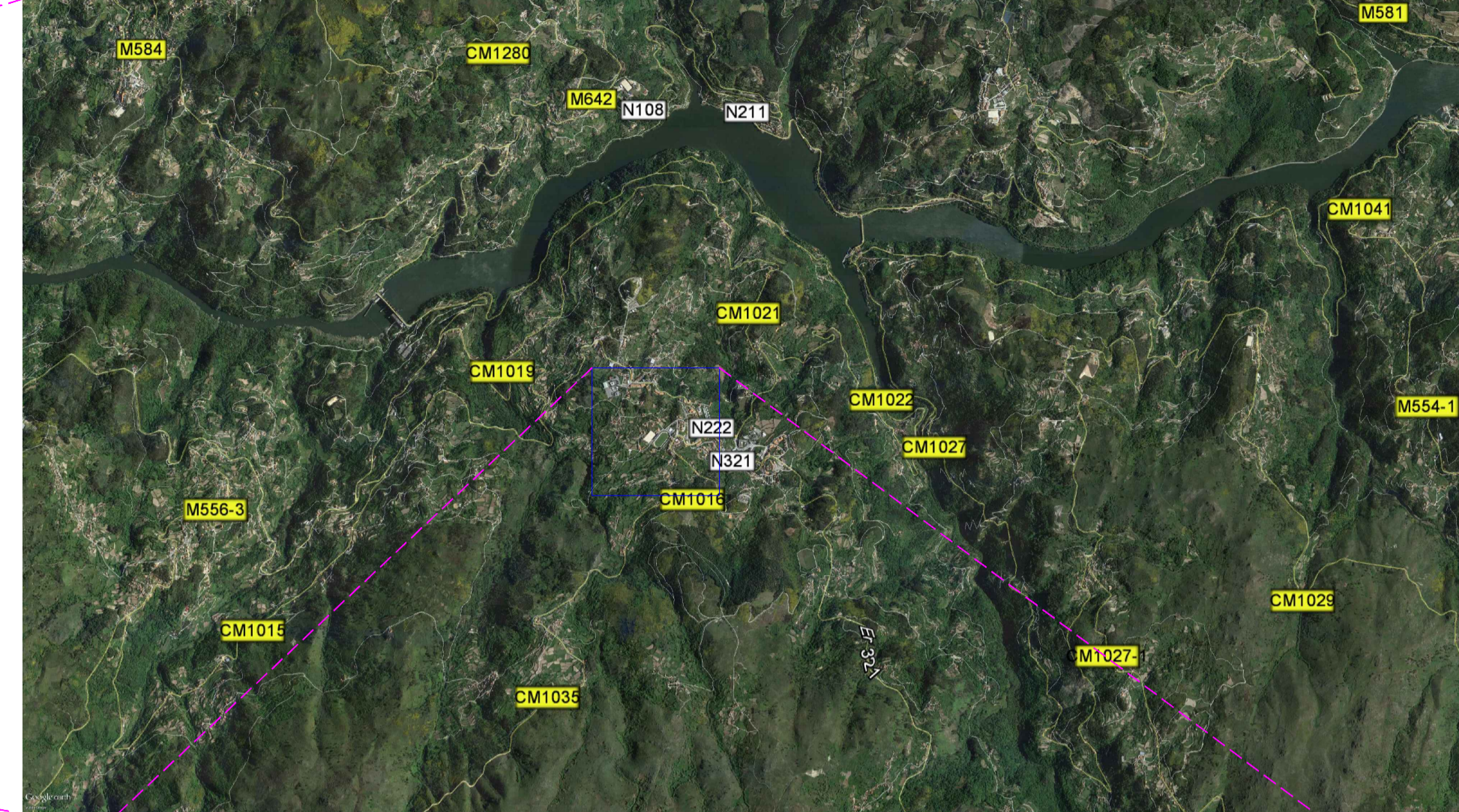
Localização na imagem aérea (google earth 2015)
