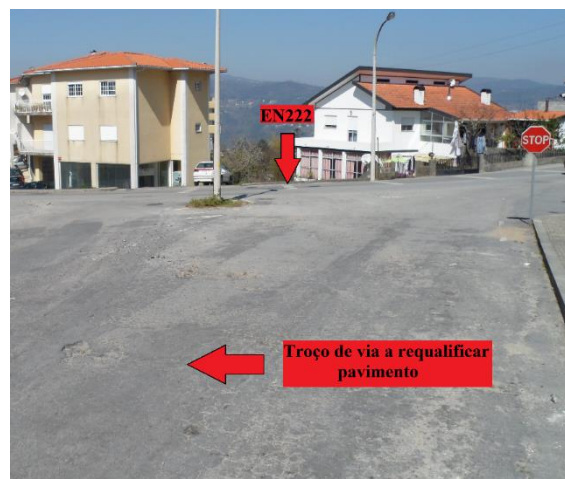
Figura 14 – Troço de via a requalificar pavimento
