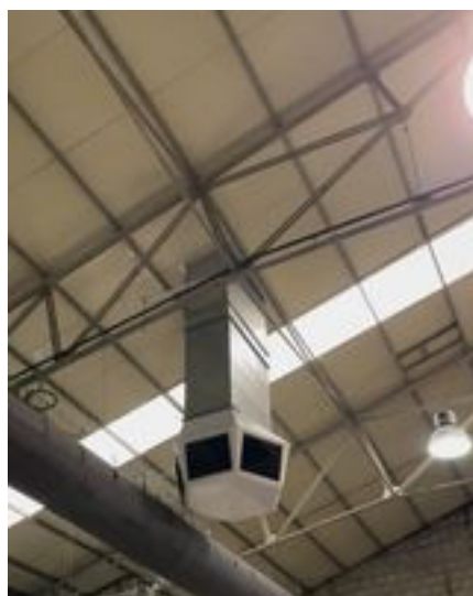
Figura 4-17: Arrefecedor adiabático instalado na MREF
