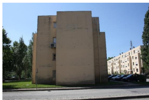
Figura 4.10 – Bloco C2, alçado lateral. Orientação: sudoeste
