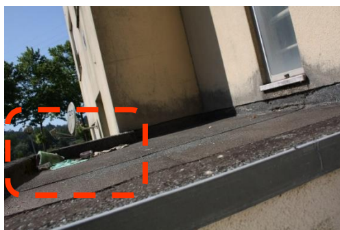
Figura 4.72 – Bloco F, cobertura da pala da entrada do bloco
