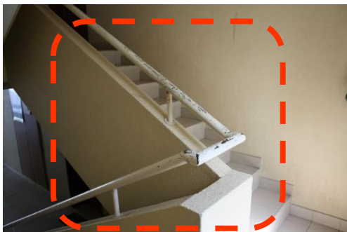
Figura 4.80 – Bloco C2, caixa de escadas
