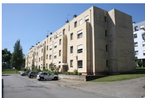
Figura 4.19 – Bloco F, entrada. Orientação: sudeste
