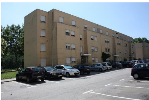
Figura 4.11 – Bloco C3, entrada. Orientação: noroeste
