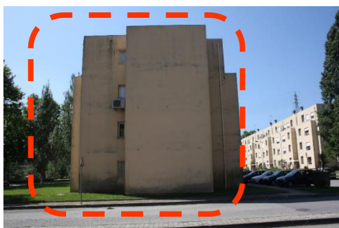
Figura 4.47 – Bloco C2, marcação de pisos em empenas
