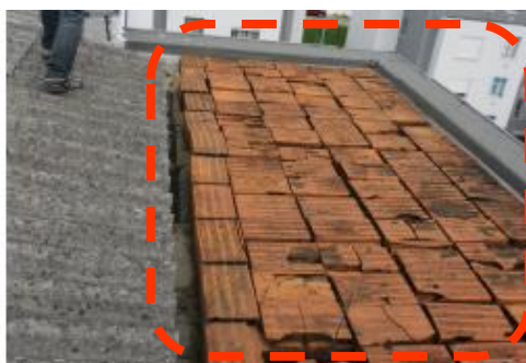
Figura 4.68 – Bloco D2, cobertura plana lateral
