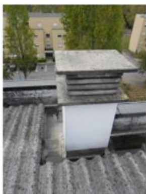
Figura 4.26 – Bloco D2, chaminé de ventilação
