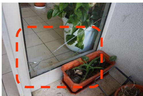
Figura 4.86 – Bloco C2, porta de entrada do bloco
