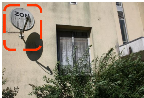
Figura 4.44 – Bloco F, equipamento elétrico
