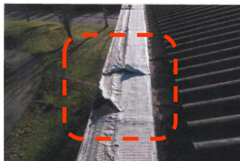
Figura 4.70 – Bloco D2, telas de impermeabilização na cobertura inclinada
