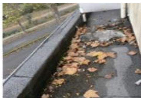
Figura 4.30 – Bloco D2, cobertura secundária
