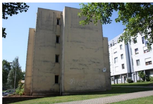
Figura 4.22 – Bloco D2, alçado lateral.
