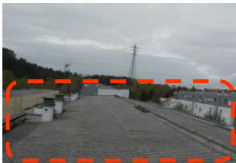
Figura 4.66 – Bloco D2, chapas de cobertura em fibrocimento
