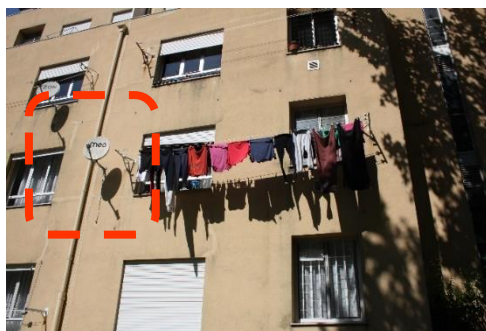
Figura 4.46 – Bloco C3, equipamento elétrico
