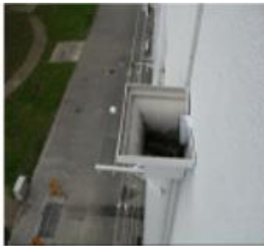
Figura 4.33– Bloco D2, tubo de queda
