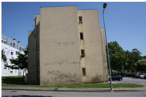
Figura 4.17 – Bloco D2, alçado lateral. Orientação: nordeste.
