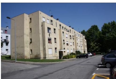
Figura 4.15 – Bloco D2, entrada.
