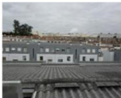
Figura 4.27 – Bloco D2, cobertura inclinada
