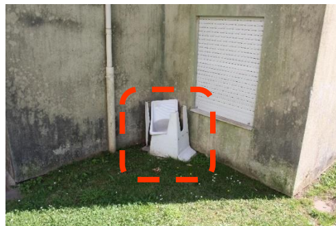
Figura 4.63 – Bloco F, espaço exterior envolvente
