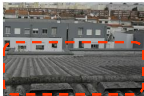
Figura 4.67 – Bloco D2, Chapas de cobertura em fibrocimento
