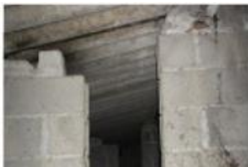
Figura 4.25 – Bloco D2, desvão da cobertura
