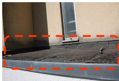
Figura 4.73 – Bloco F, cobertura da pala da entrada do bloco
