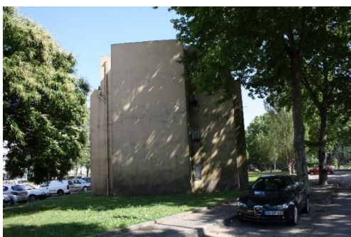
Figura 4.9 – Bloco C2, alçado lateral. Orientação: nordeste
