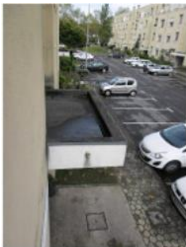
Figura – 4.31 Bloco F, cobertura secundária da entrada do bloco
