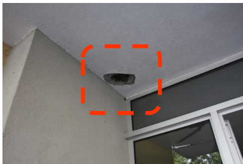
Figura 4.76 - Bloco C2, perfuração na pala da entrada
