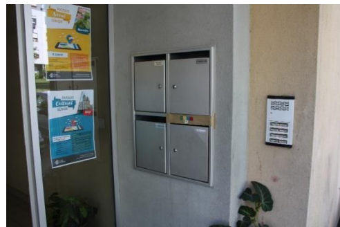
Figura 4.40 – Bloco C2, recetáculos postais e intercomunicador
