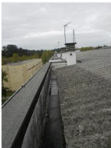
Figura 4.28 –Bloco D2, platibanda
