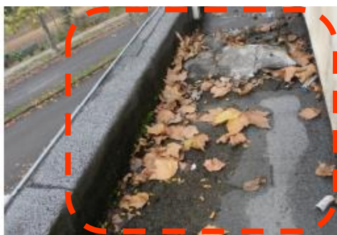
Figura 4.71– Bloco D2, cobertura plana da construção avançada
