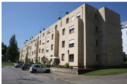
Figura 4.35 – Bloco F, fachada
