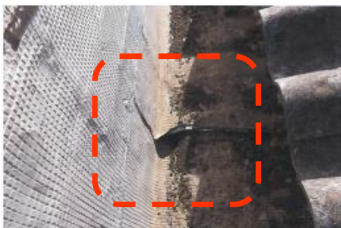
Figura 4.69 – Bloco D2, telas de impermeabilização na cobertura inclinada
