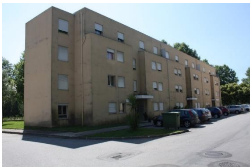
Figura 4.7 – Bloco C2, entrada. Orientação: noroeste
