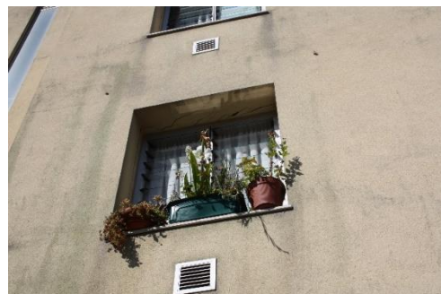
Figura 4.36 – Bloco D2, grelha de ventilação
