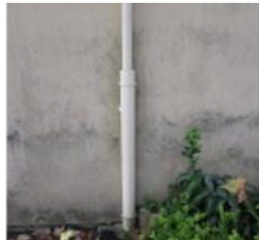
Figura 4.34– Bloco D2, tubo de queda com proteção
