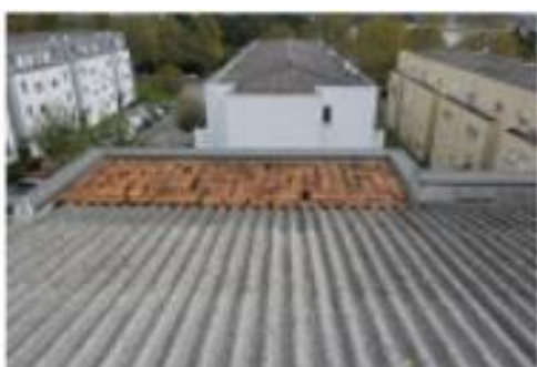
Figura 4.29 – Bloco D2, cobertura secundária
