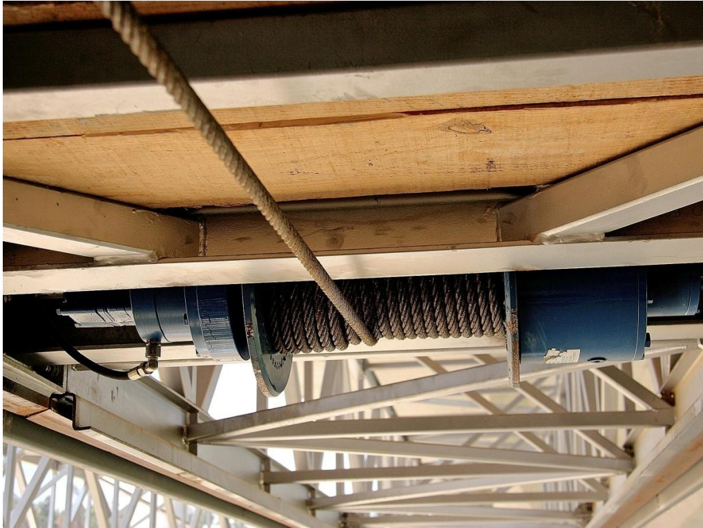
Figura 75 – Enrolamento do cabo de tracção para avanço do cimbra utilizado no viaduto sobre o rio Sousa (12-05-2005)
