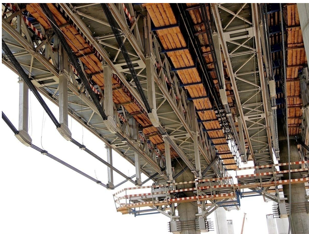
Figura 78 – Vista inferior do cimbra utilizado no viaduto sobre o rio Sousa (12-05-2005)
