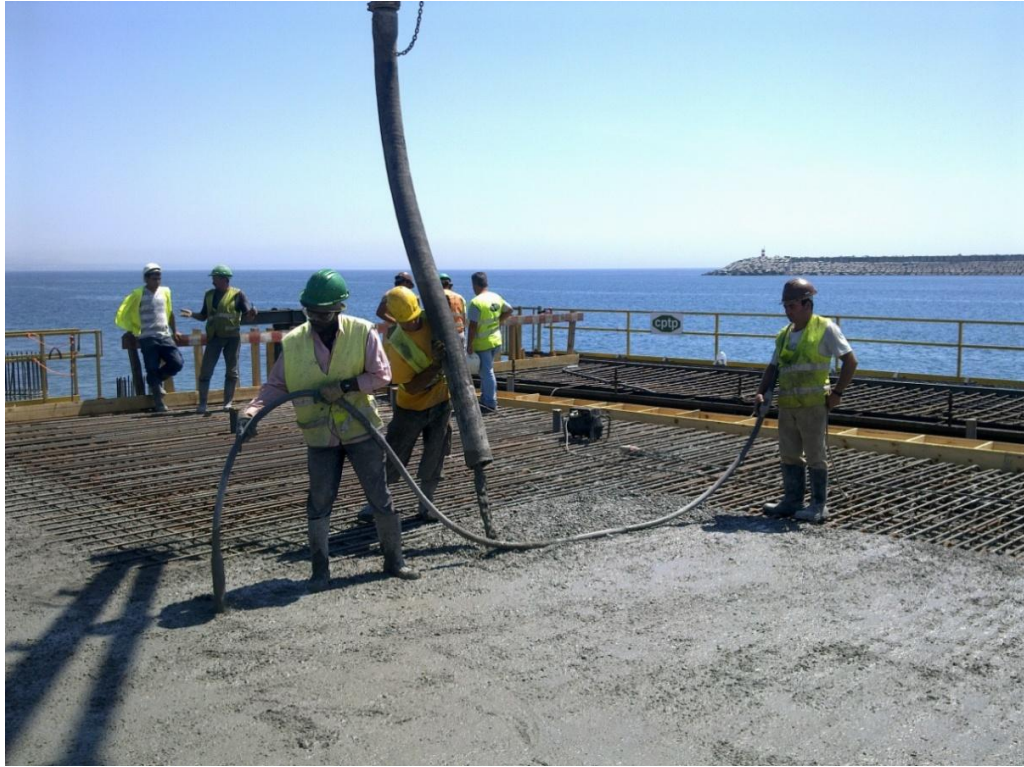
Figura 58 – Betonagem do tabuleiro (03-08-2010)
