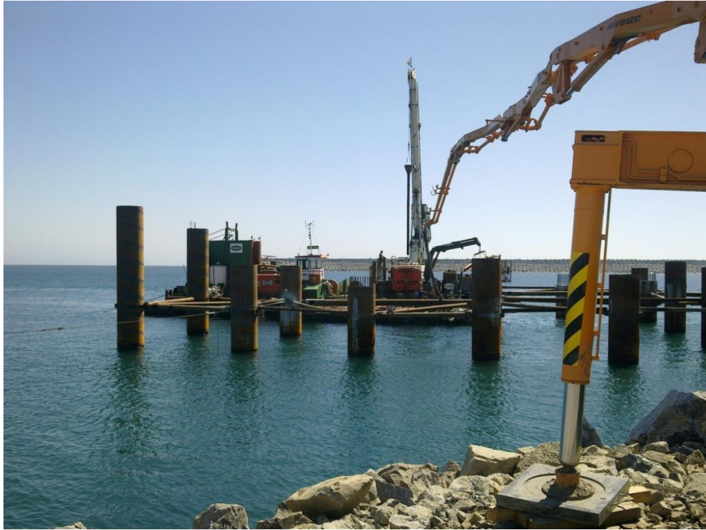
Figura 41 – Betonagem de estaca (05-08-2010)
