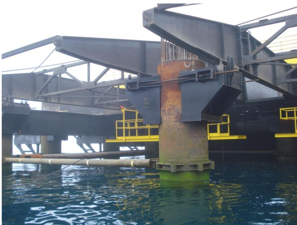
Figura 81 – Apoio do cimbres (29-06-2010)
