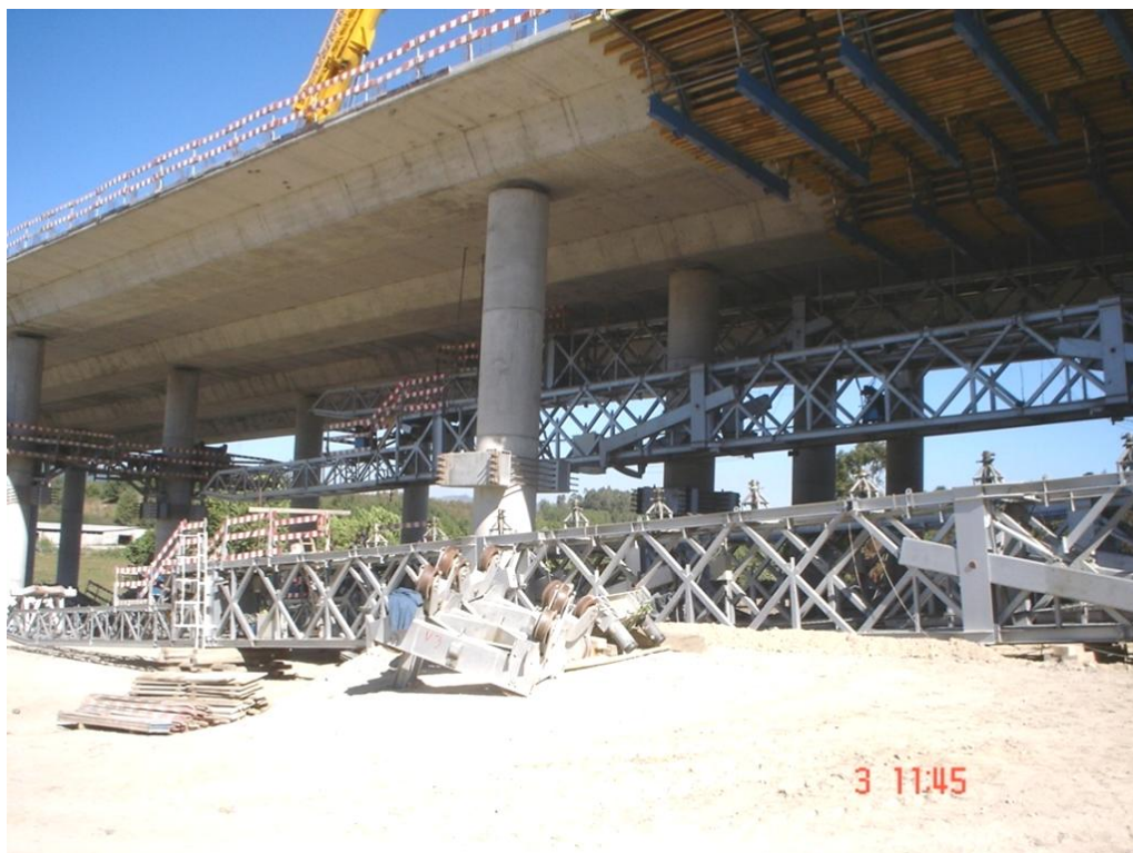
Figura 83 – Desmontagem final do cimbre utilizado no 2º viaduto sobre o rio Sousa, com descida dos elementos para o chão (03-10-2005)
