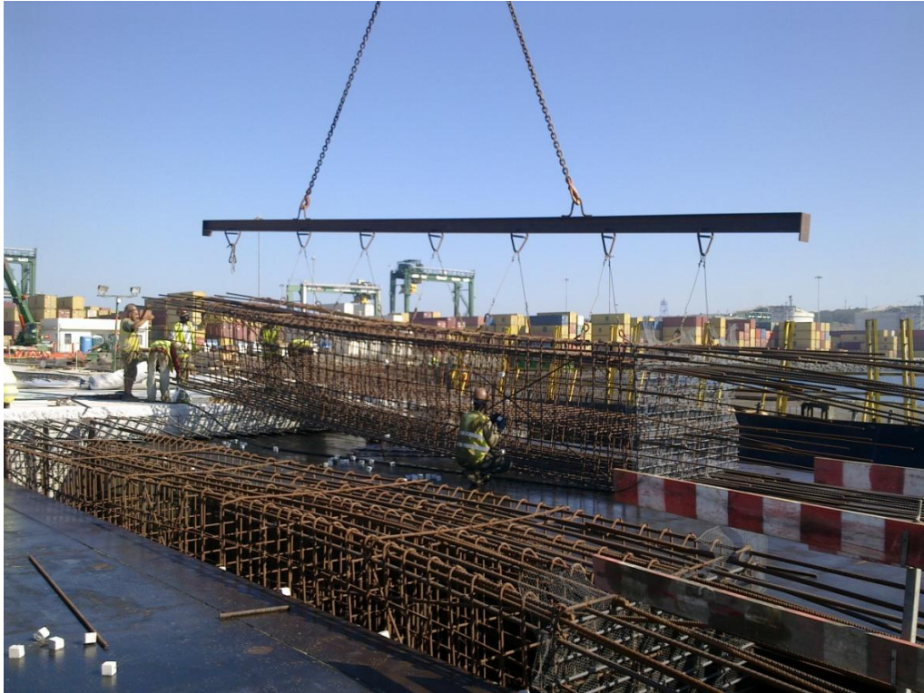
Figura 54 – Colocação das armaduras (06-08-2010)
