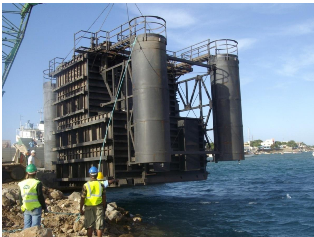
Figura 8 – Colocação da cofragem dentro de água (11-01-2010)
