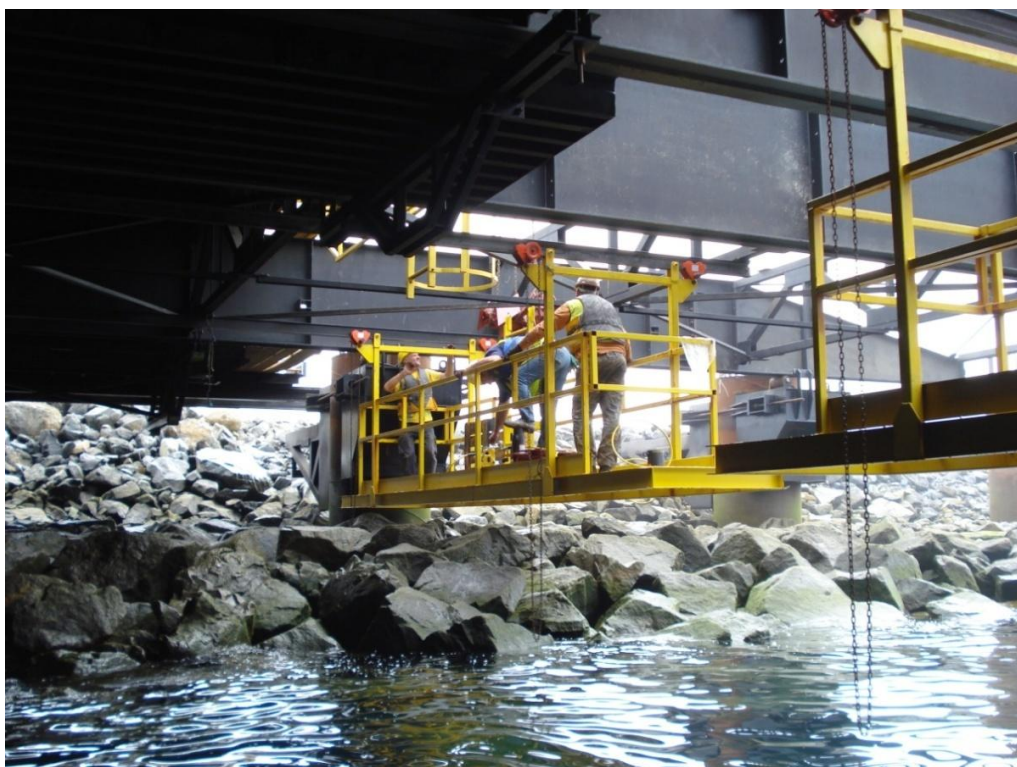
Figura 79 – Plataformas inferiores ao tabuleiro (29-06-2010)
