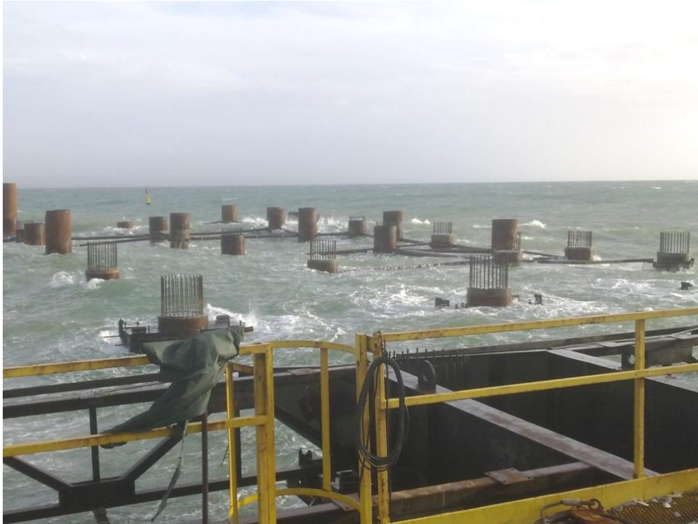
Figura 70 – Paragem dos trabalhos devido às condições meteorológicas e de mar adversas (07-12-2010)
