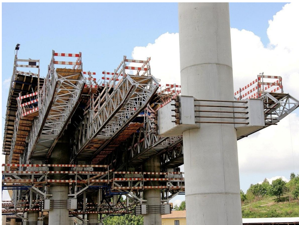
Figura 80 – Colares de atrito utilizados no viaduto sobre o rio Sousa (12-05-2005)
