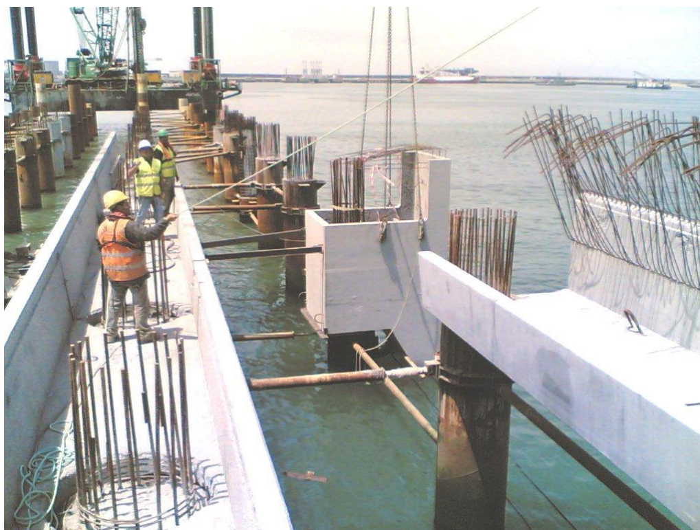
Figura 17 – Montagem dos canaletes e escudetes (30-06-2010)
