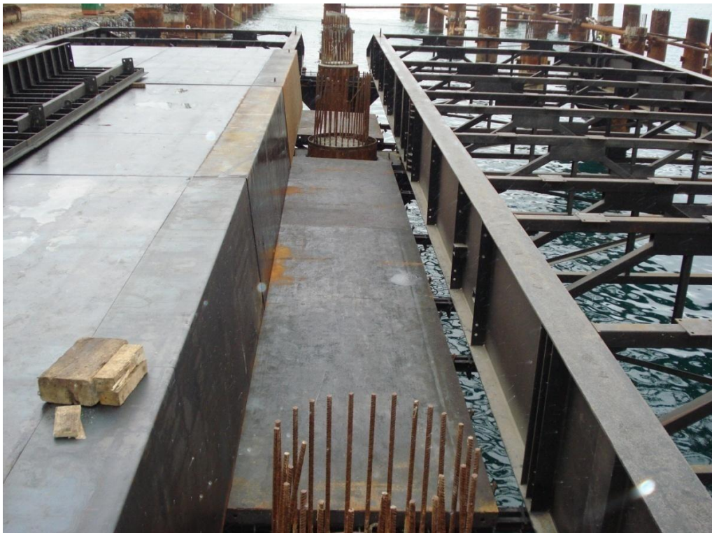
Figura 77 – Montagem da cofragem directamente sobre a estrutura do cimbra (11-06-2010)
