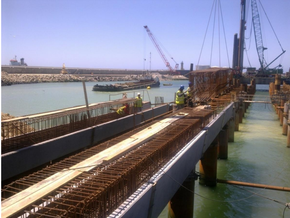
Figura 18 – Montagem das armaduras nos canaletes (15-07-2010)
