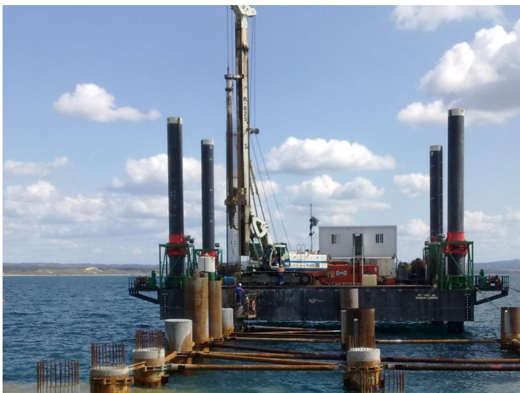
Figura 68 – Perfuração da estaca com equipamento sobre jack up (22-03-2011)
