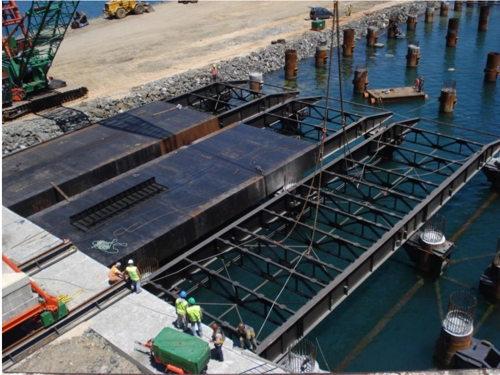
Figura 50 – Montagem do cimbra (15-06-2010)
