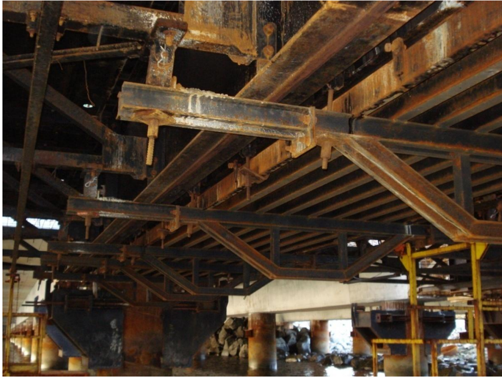
Figura 74 – Aspecto do cimbre 4 meses após a sua montagem (17-11-2010)
