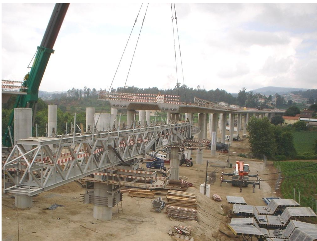
Figura 82 – Desmontagem do cimbra utilizado no 1º viaduto sobre o rio Sousa, deixando último troço para executar com cimbra ao solo (29-06-2005)
