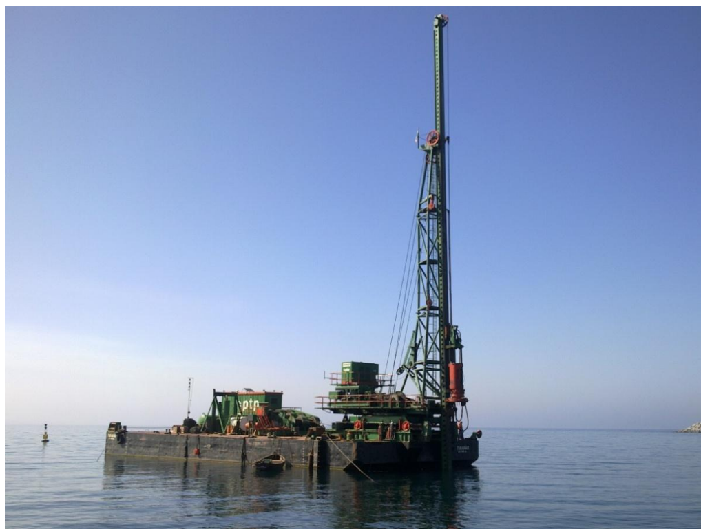
Figura 36 – Equipamento de cravação (03-08-2010)
