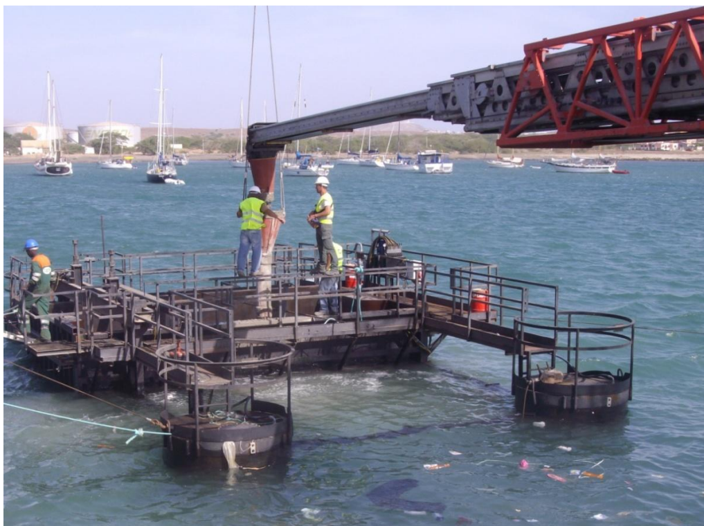
Figura 11 – Betonagem do muro com a cofragem flutuante (14-01-2010)
