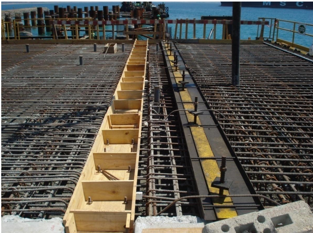
Figura 55 - Caleiras para carril e passagem de cabos (03-08-2010)
