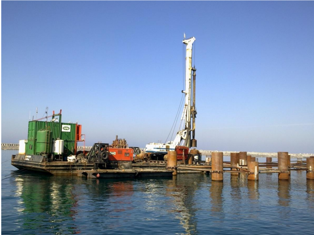
Figura 38 – Equipamento de perfuração (03-08-2010)
