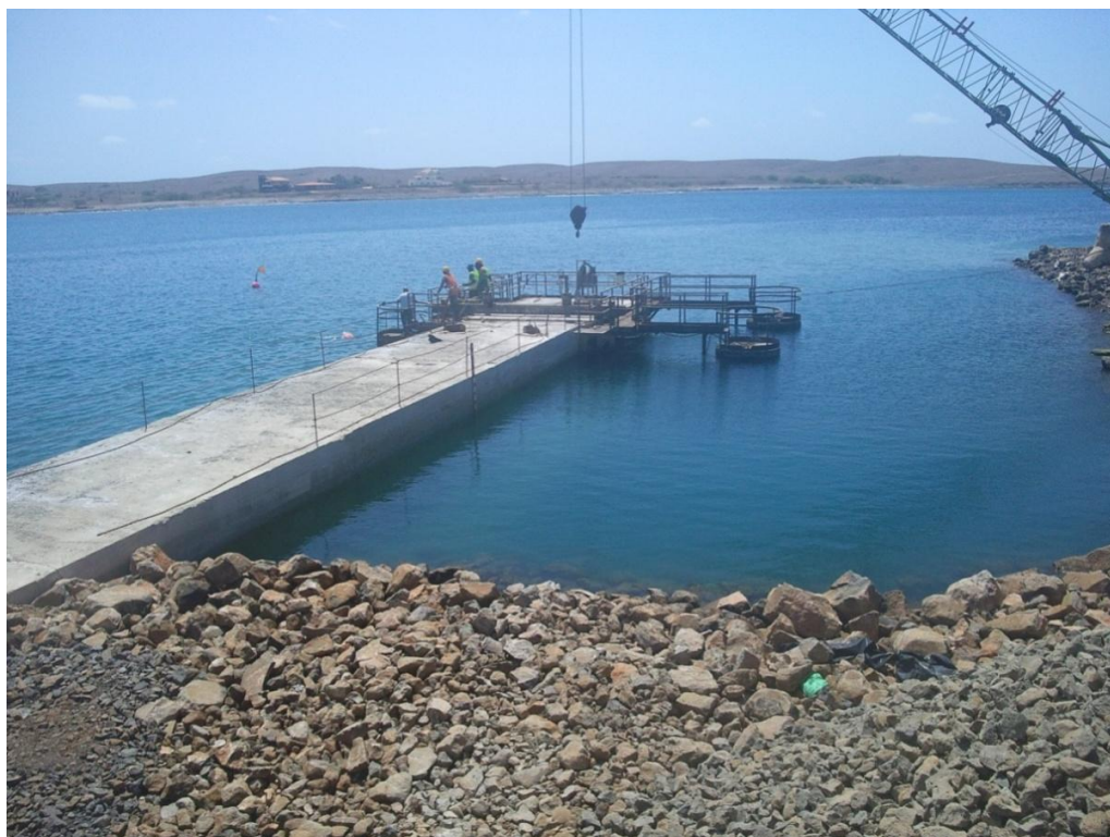
Figura 12 – Muro em construção (08-04-2010)
