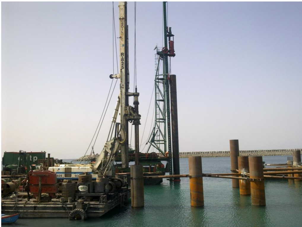
Figura 39 – Execução das estacas (11-08-2010)
