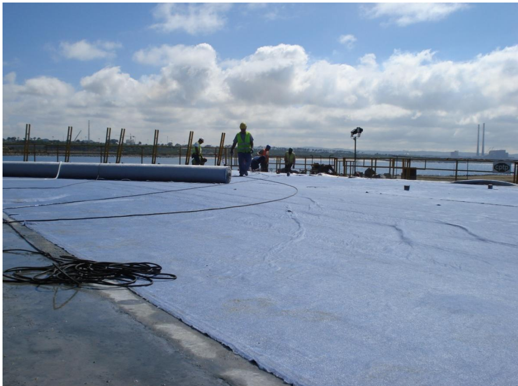
Figura 59 – Aplicação de cobertura húmida durante a cura do betão (21-07-2010)
