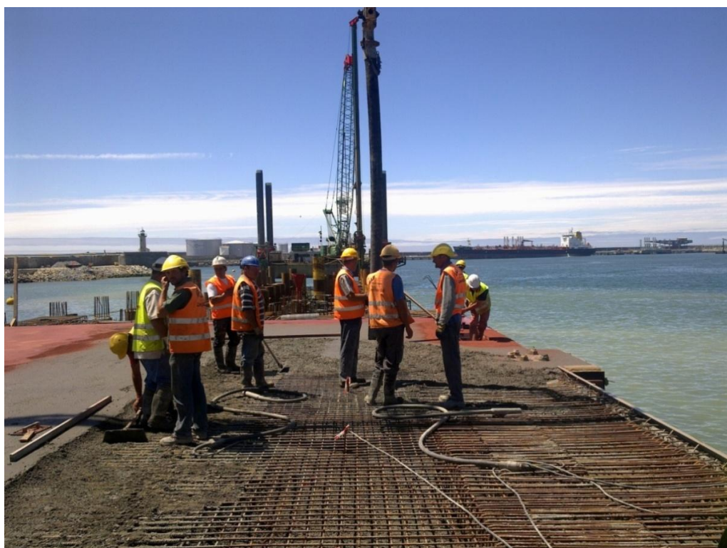
Figura 20 – Betonagem do tabuleiro (20-07-2010)
