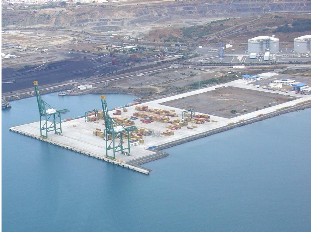
Figura 23 – Terminal XXI antes da ampliação (12-06-2006)
