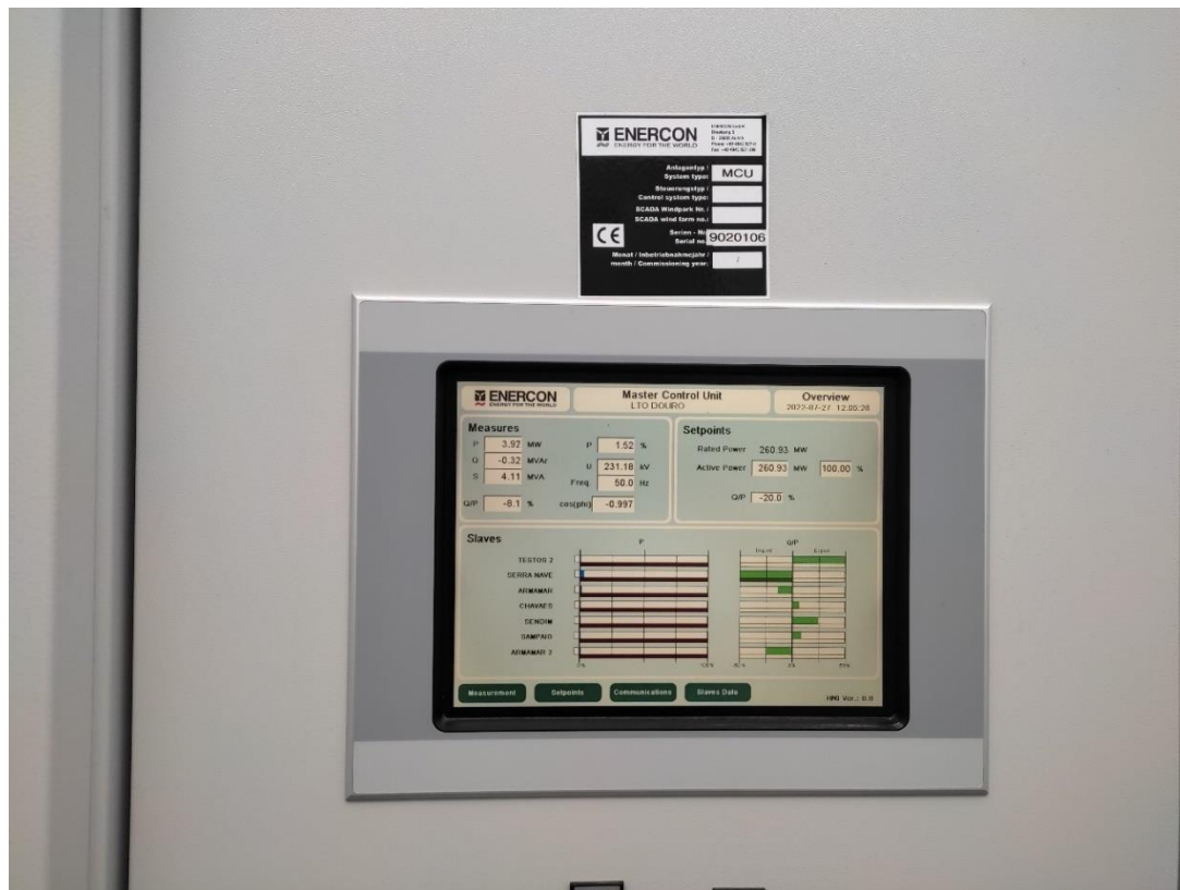
Figura 12 - Sistema de monitorização SCADA
