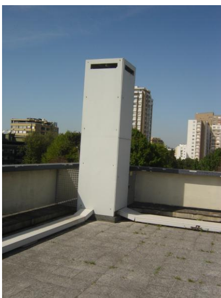
Figura 47 – Equipamento instalado no terraço
