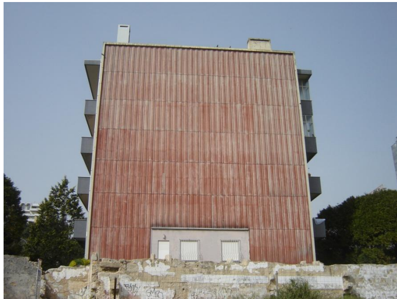
Figura 44 – Placas de fibrocimento e alvenaria (Alçado Sul)
