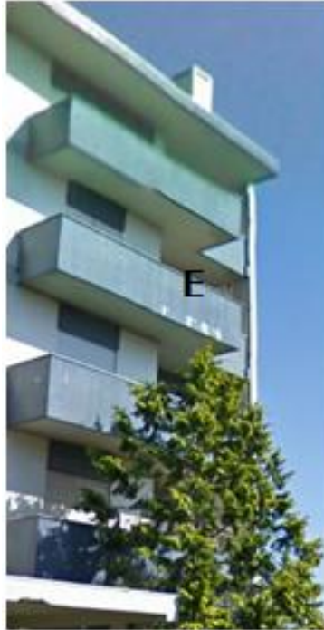
Figura 115 – Efluentes na varanda "E"
