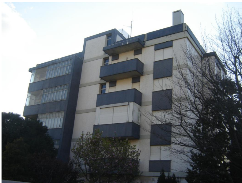
Figura 34 – Vista do alçado Nascente
