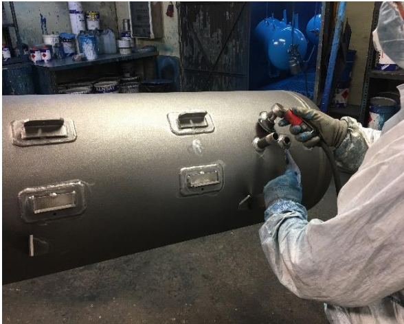
Figura 32 – Limpeza do pré-reservatório
