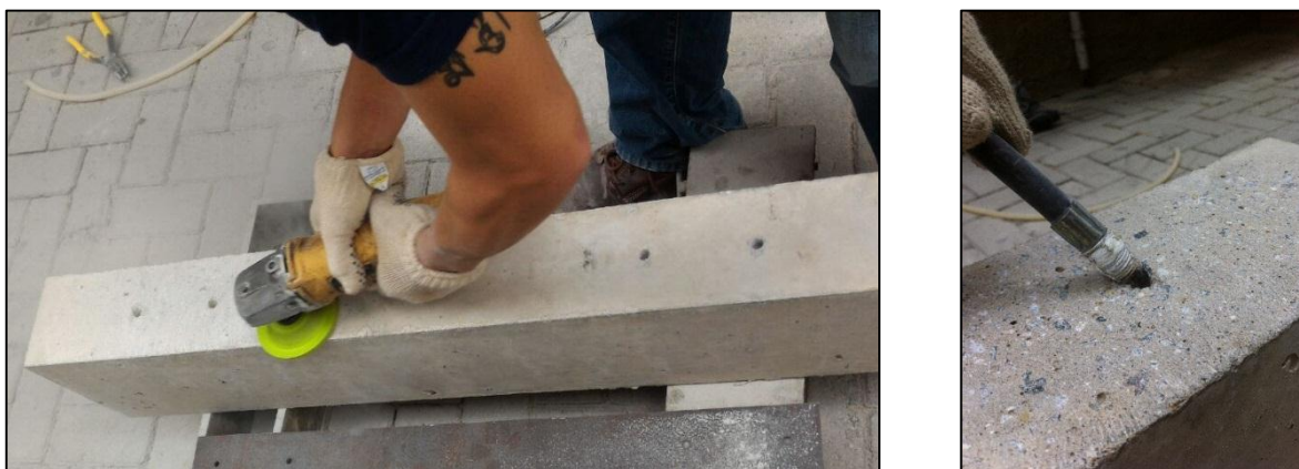
Figura 5.12 – Desbaste e limpeza da superfície de concreto.
