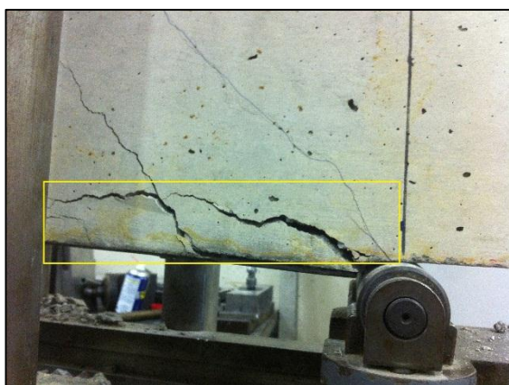
Viga V3 – Rotura por arrancamento do recobrimento.
