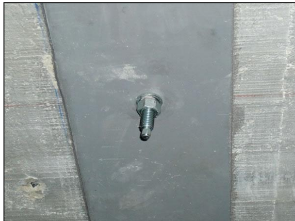
Figura 2.10 – Detalhe na colocação de buchas expansivas no reforço de uma laje (HTECNIC, 2016).
