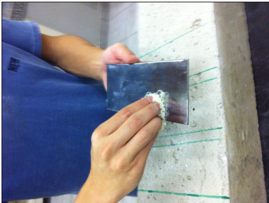
Figura 5.23 – Limpeza da chapa de aço.
