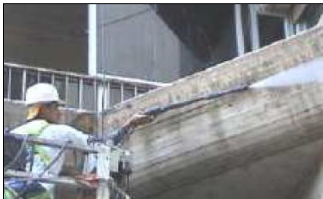
Figura 2.1 – Limpeza do concreto a jatos de água (SOUSA,2008).
