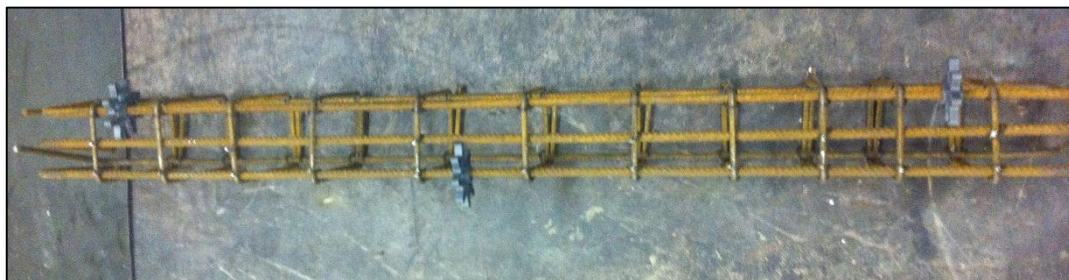
Figura 5.9 – Armadura das vigas.
