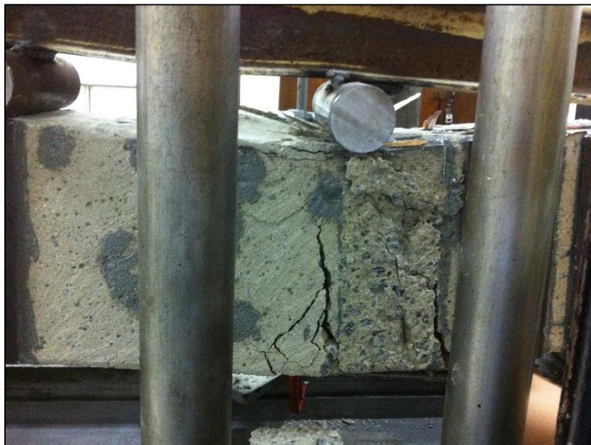
Figura 5.50 – Fissuras verticais e deslocamento da chapa lateral na viga V5.
