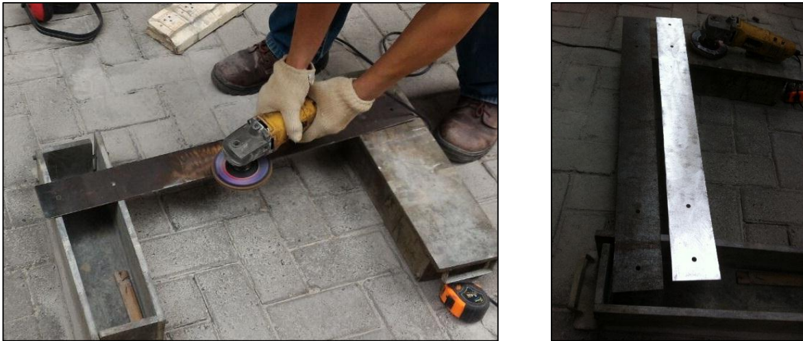
Figura 5.14 – Limpeza das chapas de aço.
