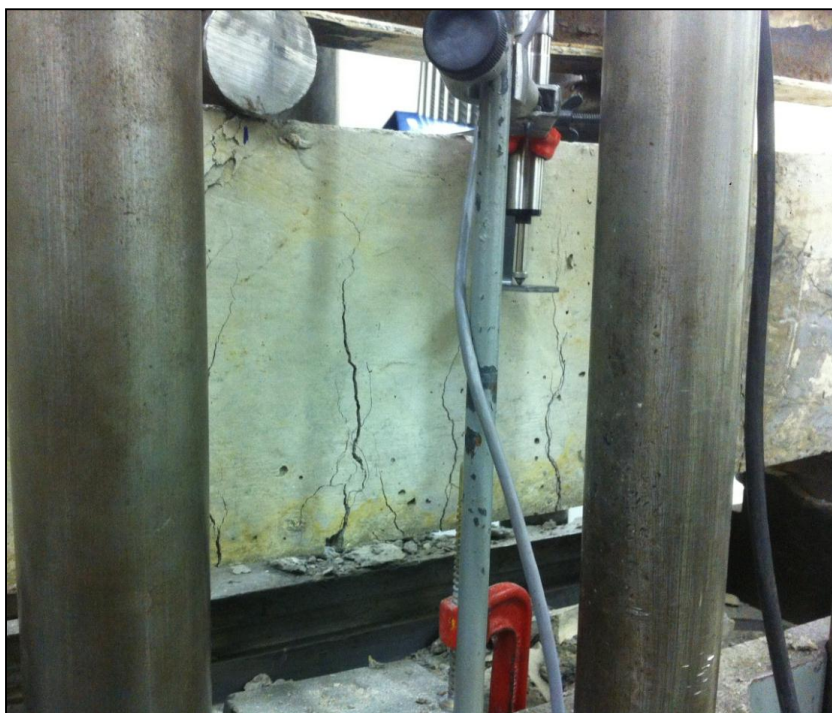
Figura 5.37 – Escoamento das armaduras na viga V2.
