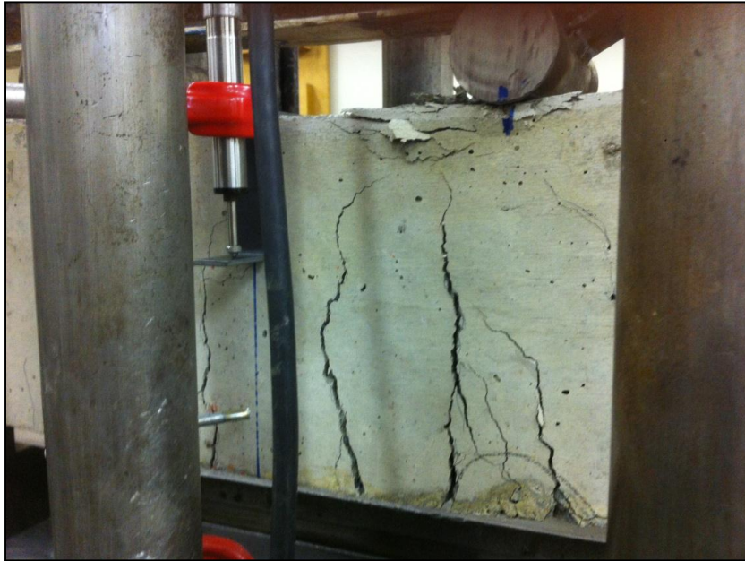
Figura 5.33 – Escoamento da armadura na viga V1.
