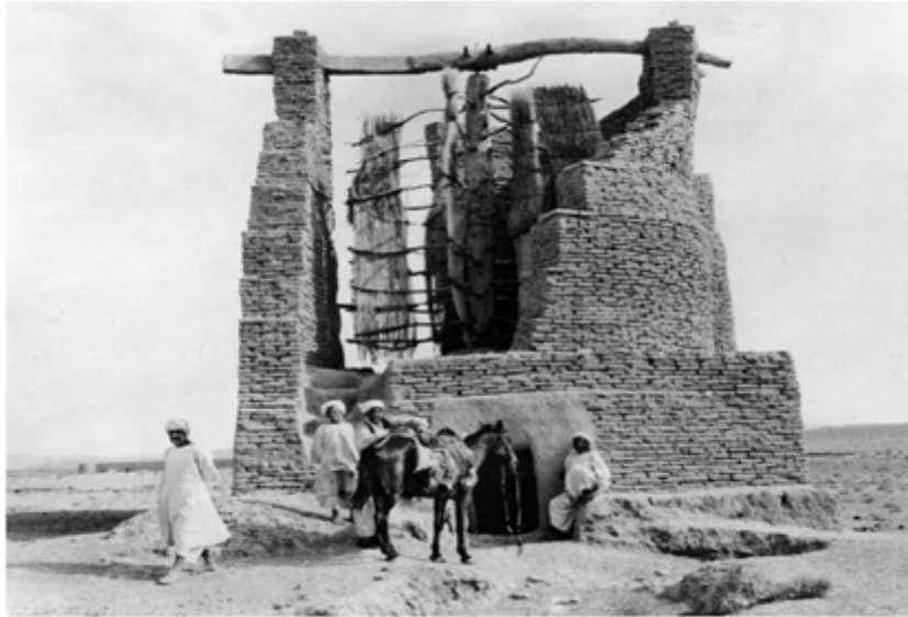
Figura 11 Moinho de vento de eixo vertical para a moagem de cereais [58]
