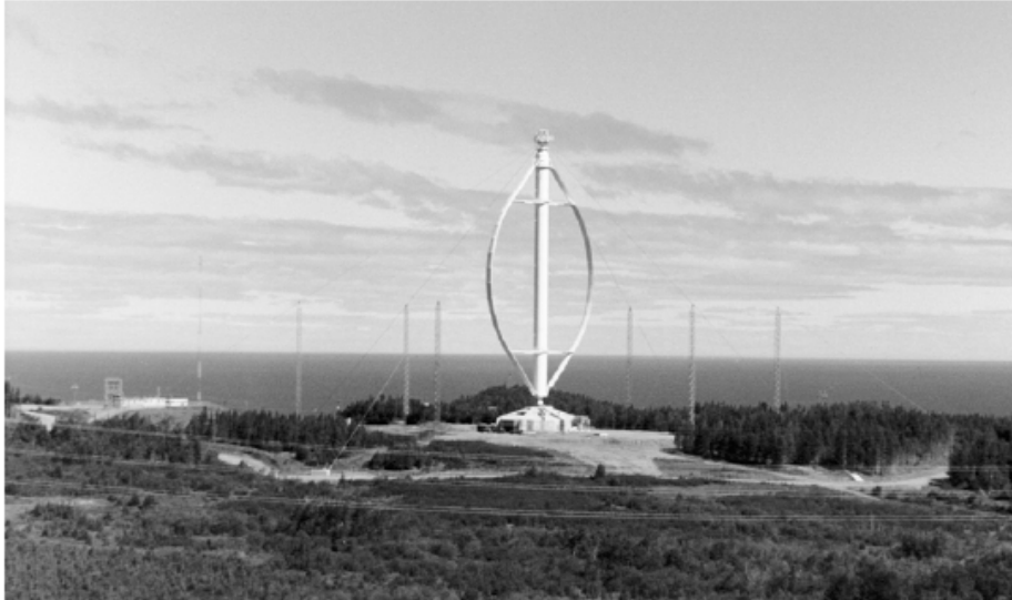
Figura 17 Turbina Darrieus Eole ,4 MW de potência, Hydro-Québec , Canadá, 1987 [58]
