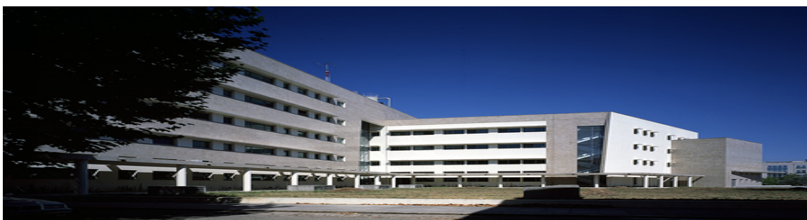
Figura 48 Edifício F, do Instituto Superior de Engenharia do Porto [55]
