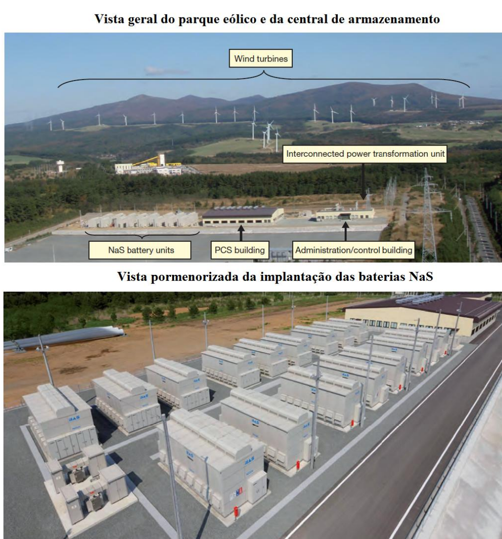
Figura 3.13 – Exemplo de aplicação no Japão de baterias de NaS, NGK
