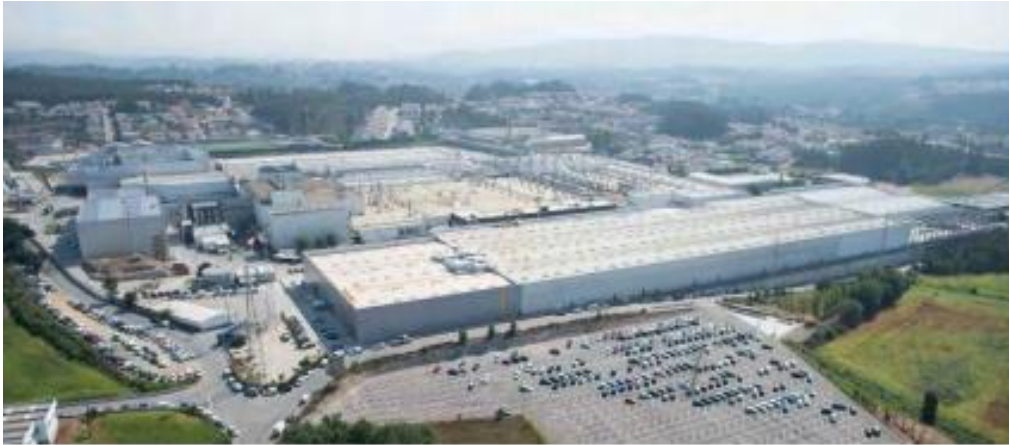
Figura 25- Instalações da Continental Mabor - Indústria de pneus S.A. (Fonte: SETE – Lousado Newsletter nº 11/2018).
